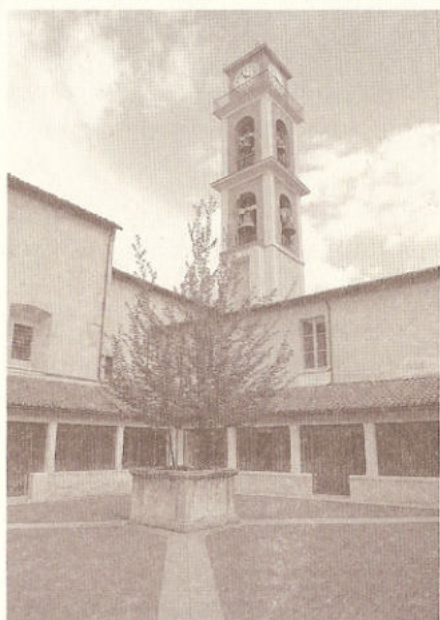
Convento, vedute dello stato attuale: il portico interno; il chiostro.
