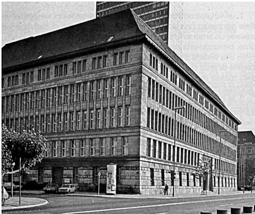
Figure 17 e 18. Uffici Mannesmann (P. Behrens), Dusseldorf 1912.
