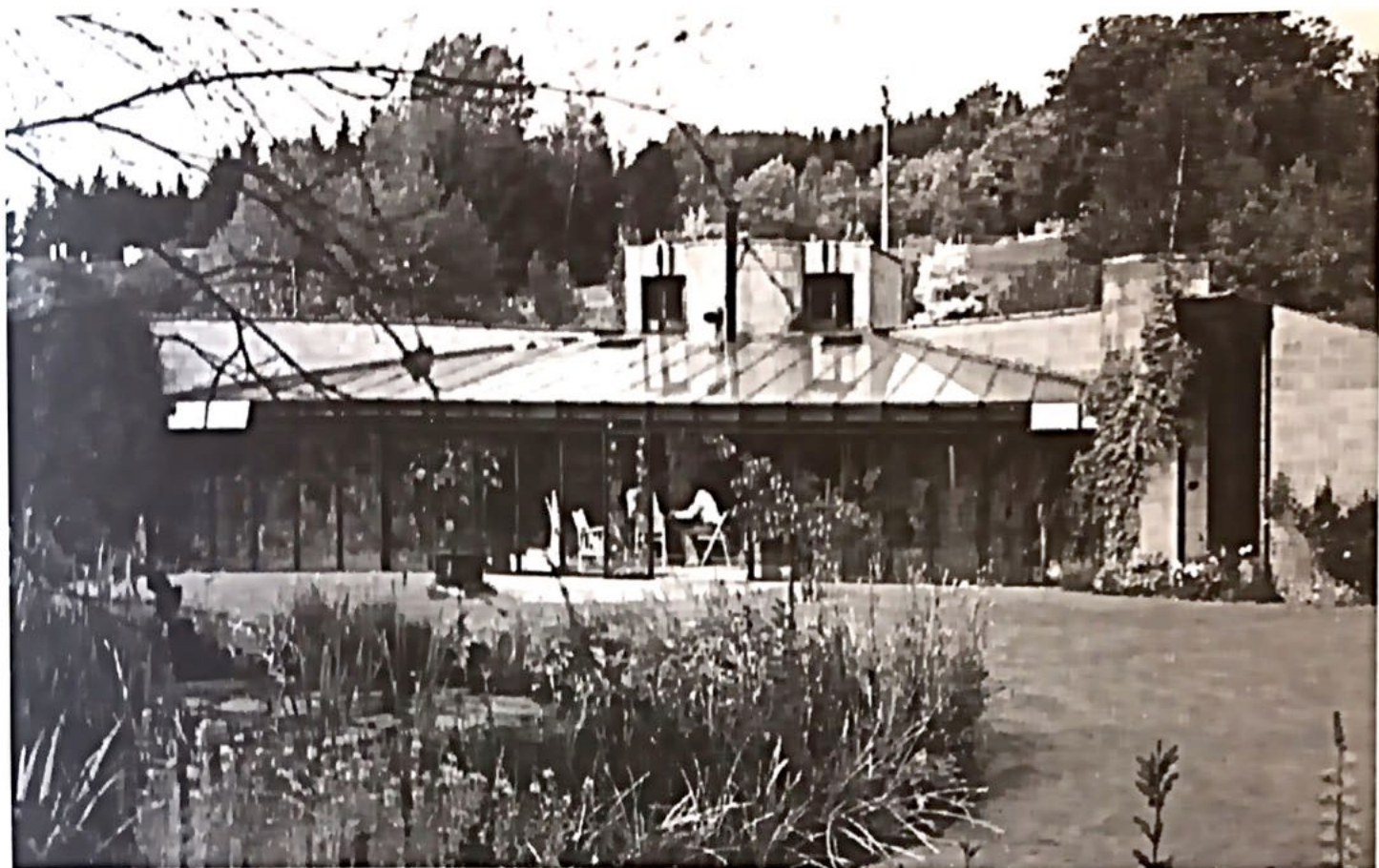
Fig. 15 Esempio di serra addossata.
