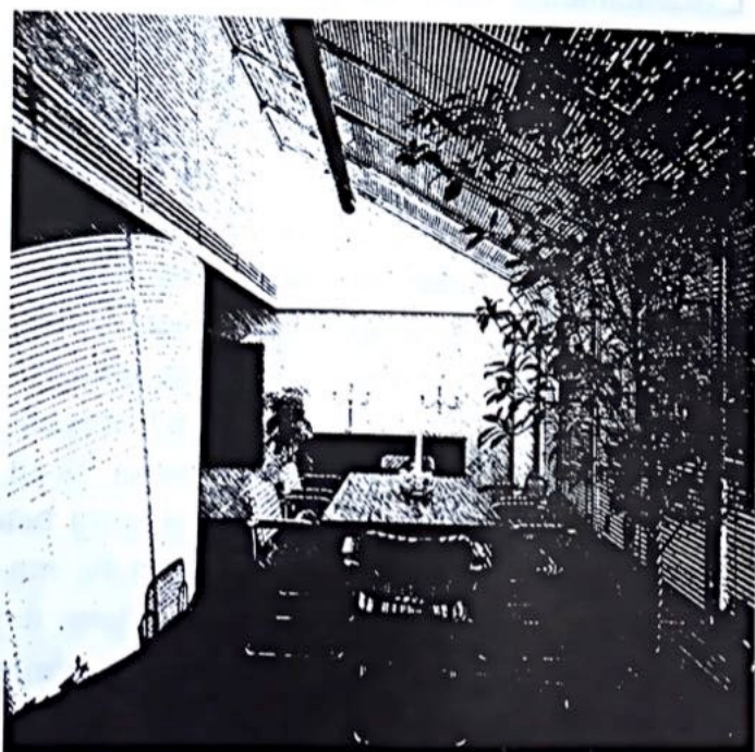
Fig. 14 Controllo dell'irraggiamento solare con schermature lamellari esterne. (immagine riprodotta dagli studenti)
