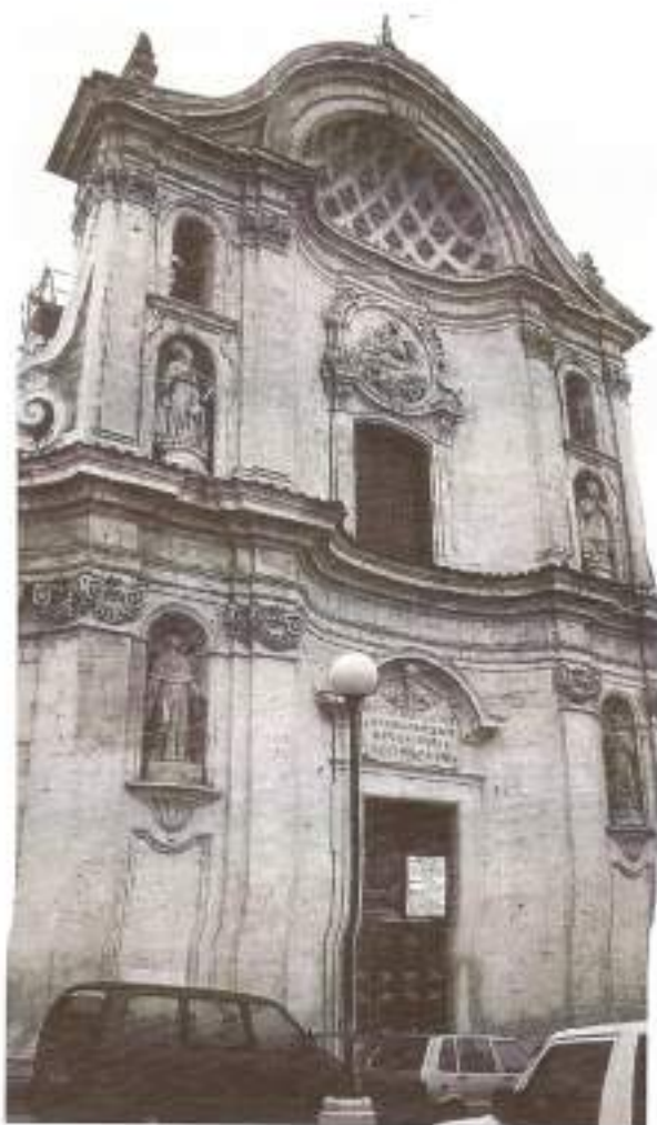
L'Aquila, "Chiesa del Suffragio", facciata; (Foto Francesco Lucantoni).
