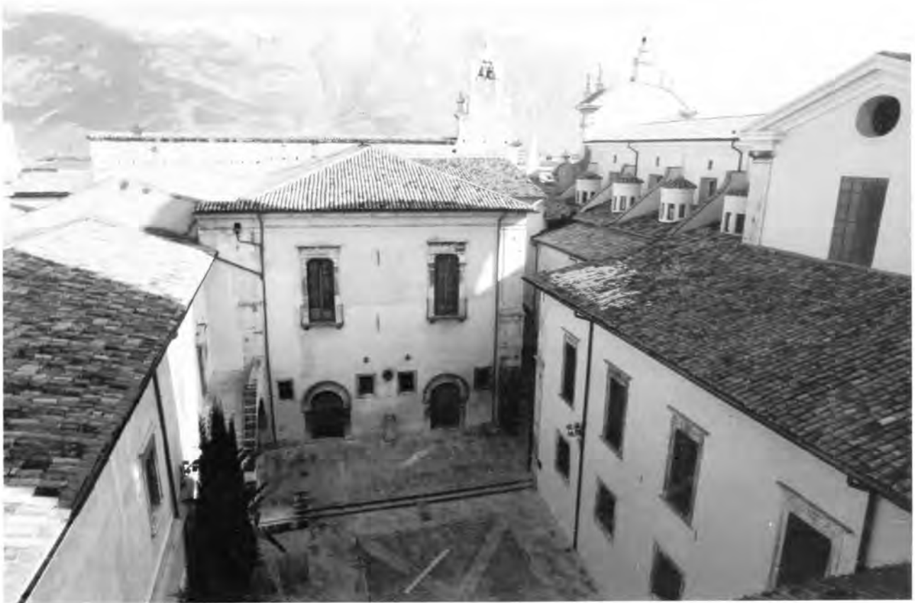
Fig. 70 - Palazzo dell'Annunziata: veduta dall'alto del corpo retrostante la facciata.
