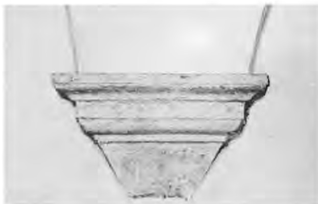
Fig. 135 - Ospedale dell'Annunziata, loggiato del piano superiore prima del restauro degli anni '60 (da MORETTI, Restauri , 1972).
