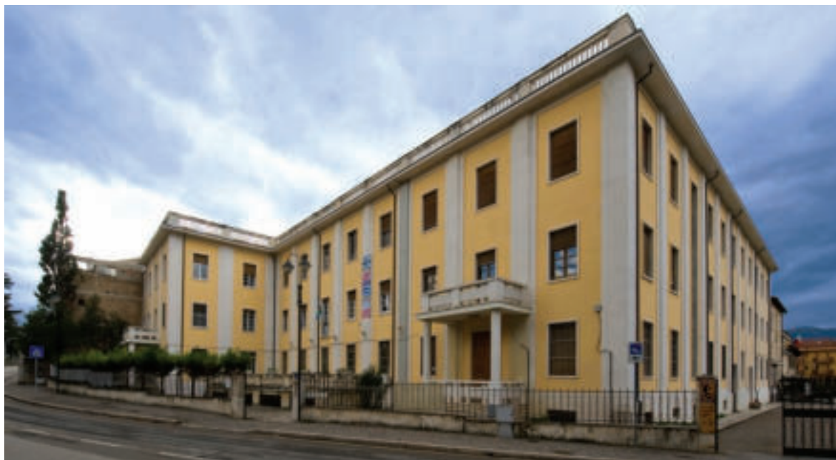
Sulmona, nuovo fabbricato del convento di S. Antonio, stato attuale.
