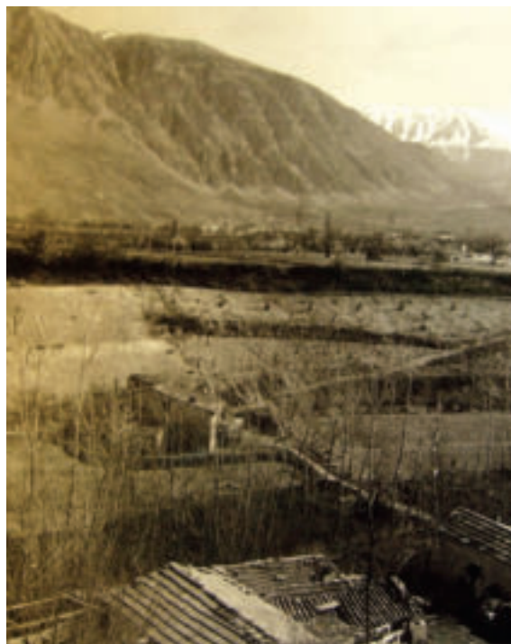
Sulmona, veduta del pianoro della Potenza prima della costruzione degli edifici di edilizia popolare e del ponte Capograssi.
