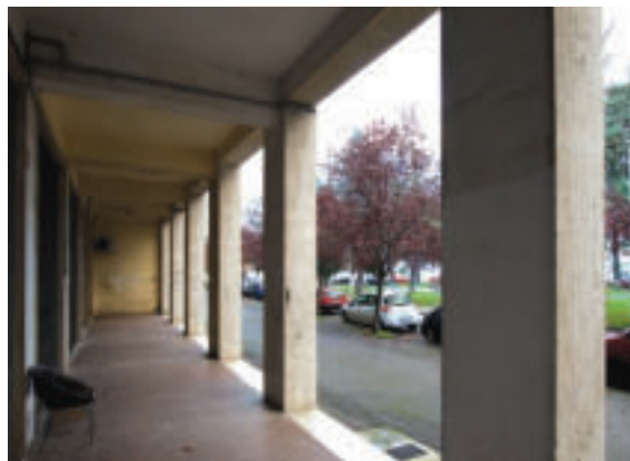
Sulmona, edificio INA-Casa lungo viale Papa Giovanni XXIII, stato attuale, vedute
