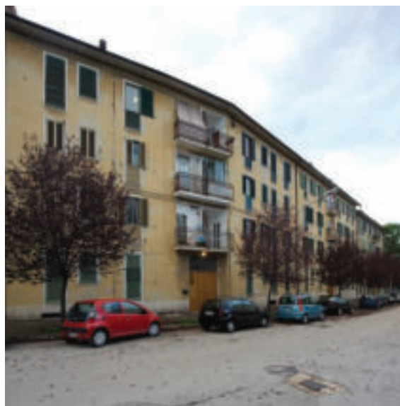
Sulmona, edificio INA-Casa lungo viale Papa Giovanni XXIII, ex nuova strada di P.R., stato attuale, prospetto anteriore.
