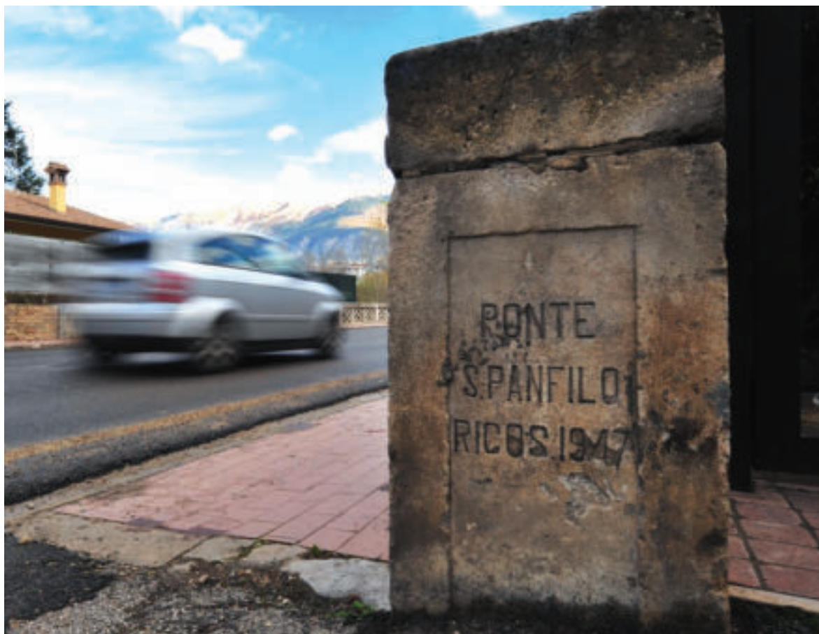
Sulmona, ponte di San Panfilo, stato attuale, particolare della spalletta con data della ricostruzione.
