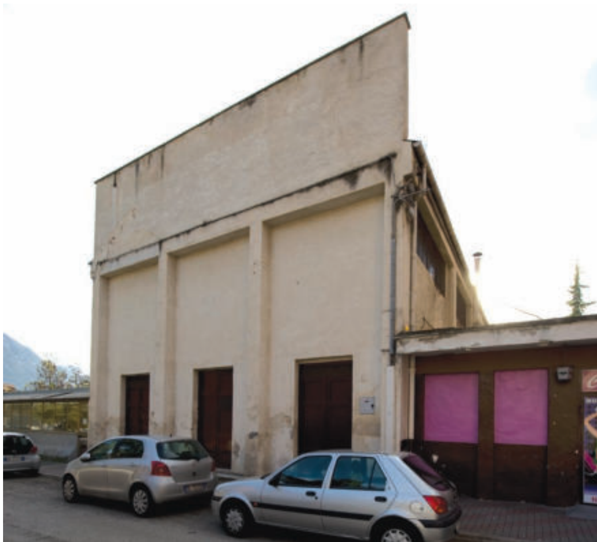
Sulmona, ex sala cinematografica del Dopolavoro Ferroviario, stato attuale.
