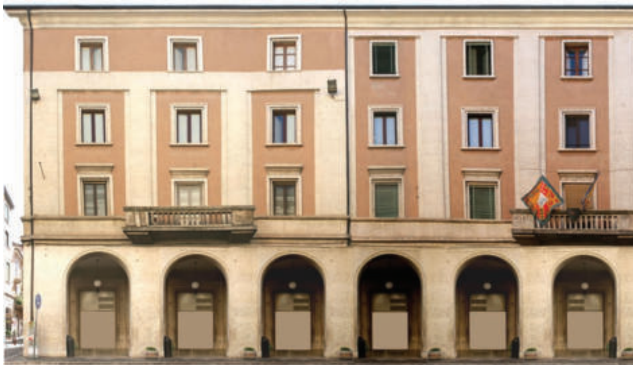
Sulmona, fabbricato in Corso Ovidio realizzato su progetto di G. Conti, stato attuale.
