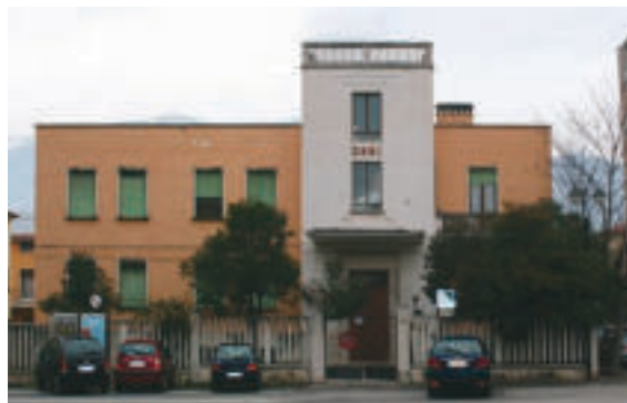
Sulmona, edificio ex ONMI, prospetto su piazzale S. Francesco di Paola (1948), stato attuale.
