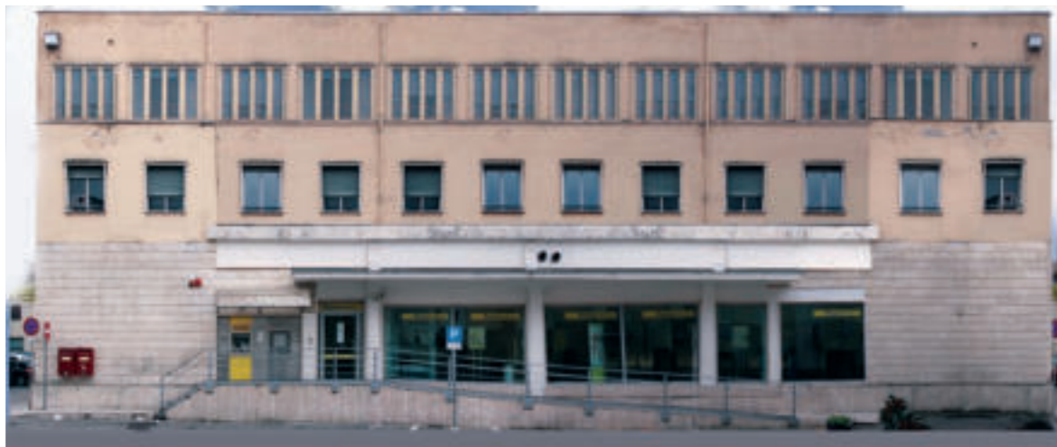
Sulmona, edificio postale in piazza Brigata Maiella, (1952), stato attuale, prospetto principale.
