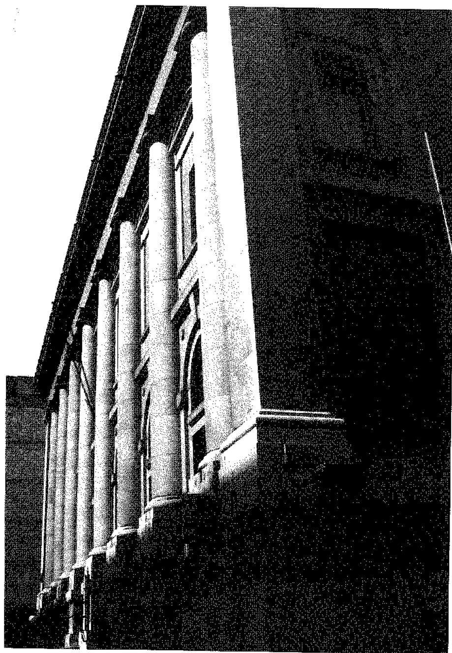
Pescara, palazzo delle Poste e Telegrafi: veduta.
