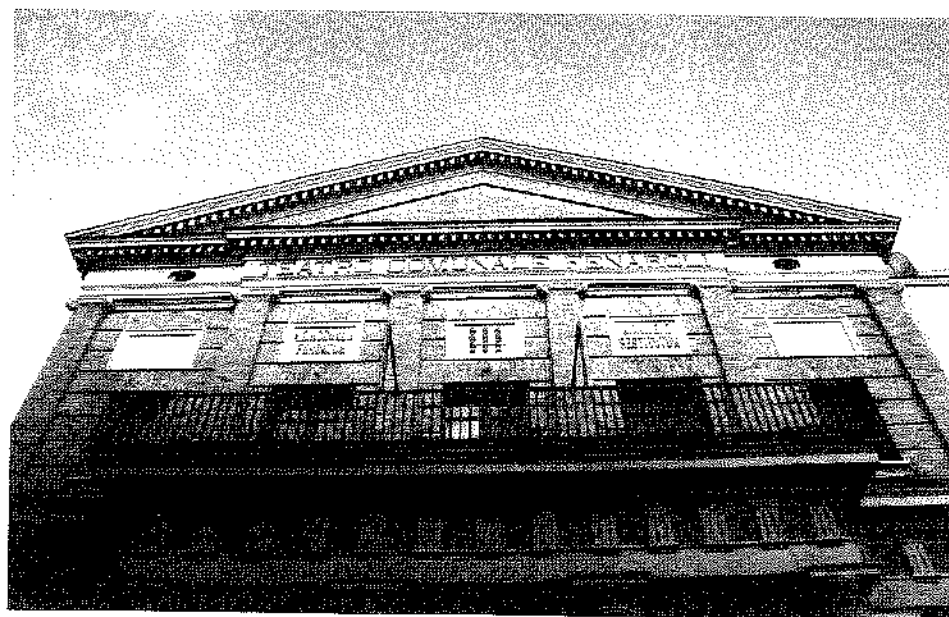
Lanciano, Teatro Fenaroli: particolare di facciata.
