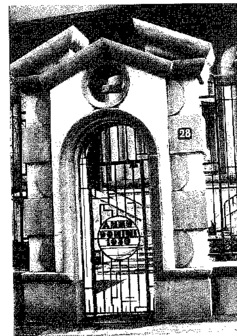
Milano, casa in via Majno: ingresso (foto d'epoca).
