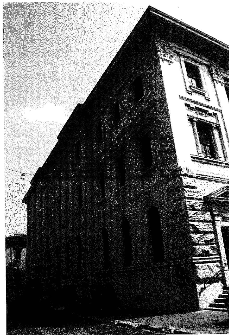
Teramo, edificio postelegrafonico: veduta.
