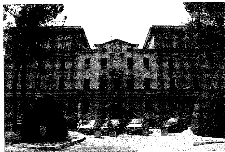
Teramo, edificio INCIS nel Rione Mezzuccelli: veduta.
