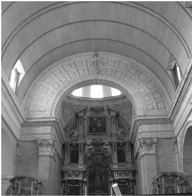
Figg. 3, 4 - Medina de Rioseco (Valladolid), chiesa di S. Cruz, particolari interni dell'impiego dell'uso del legno lamellare per riconfigurare la volta a botte (foto dell'A., 2008).
