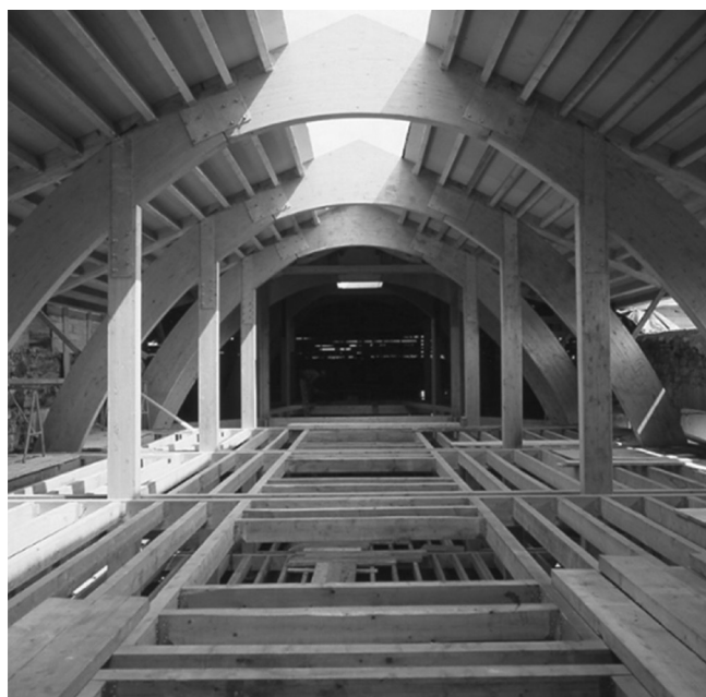
Fig. 8 - San Sebastián, convento di S. Teresa, pianta della struttura lignea e delle sezioni trasversali, a sinistra. Veduta degli archi parabolici in legno lamellare che sostengono i due nuovi livelli, a destra (da García Grinda 1998).
