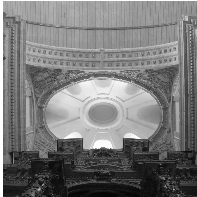
Figg. 3, 4 - Medina de Rioseco (Valladolid), chiesa di S. Cruz, particolari interni dell'impiego dell'uso del legno lamellare per riconfigurare la volta a botte (foto dell'A., 2008).
