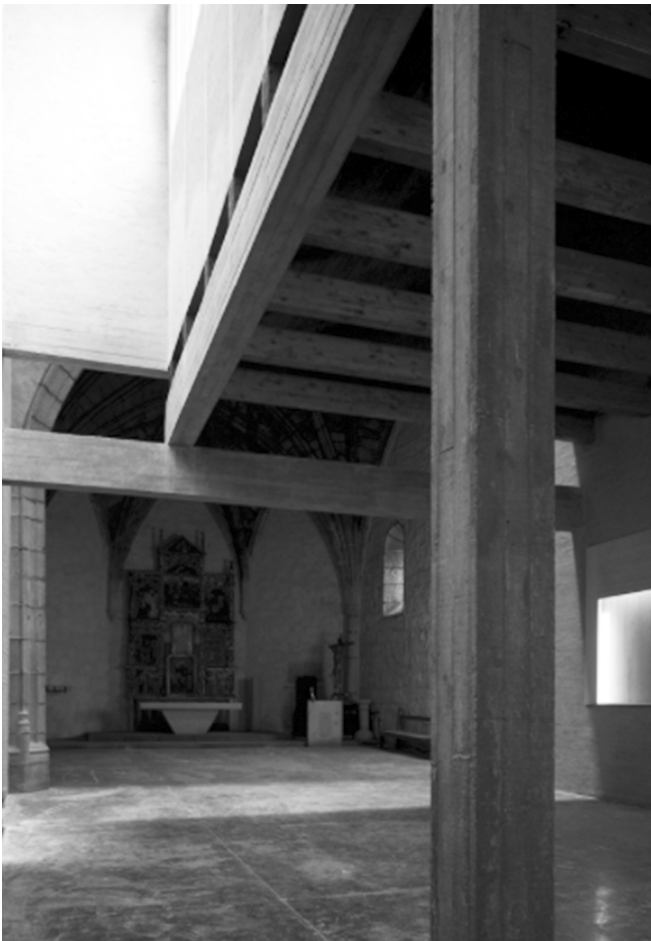
Fig. 13, 14 - Valdequedra (Madrid), chiesa di S. Lorenzo, particolari interni dell'abside e della struttura in cemento armato della copertura (da «On Diseño», 2001).
