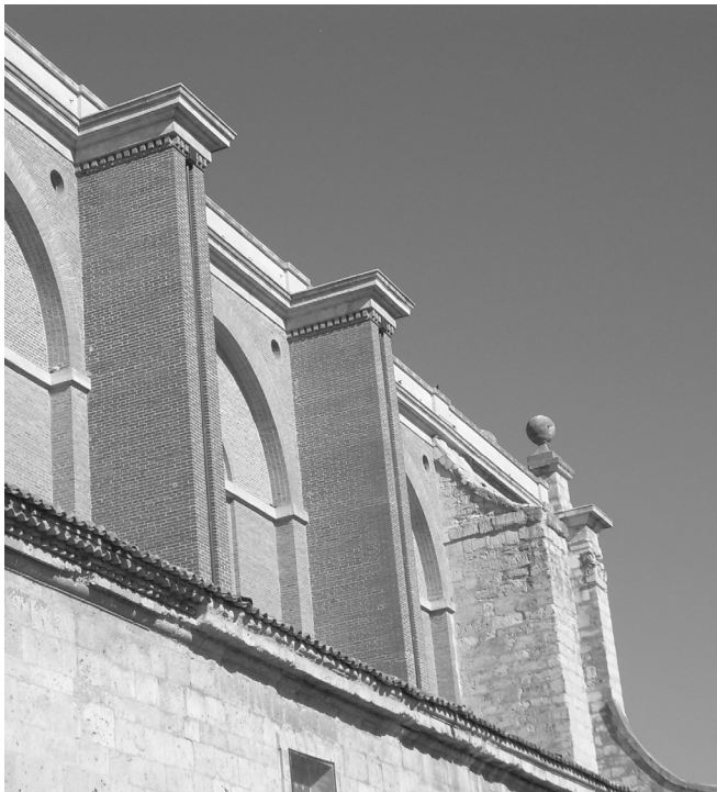
Fig. 5 - Medina de Rioseco (Valladolid), chiesa di S. Cruz, il fianco esterno caratterizzato dall'inserimento delle nuove strutture in mattoni (foto dell'A., 2008).
