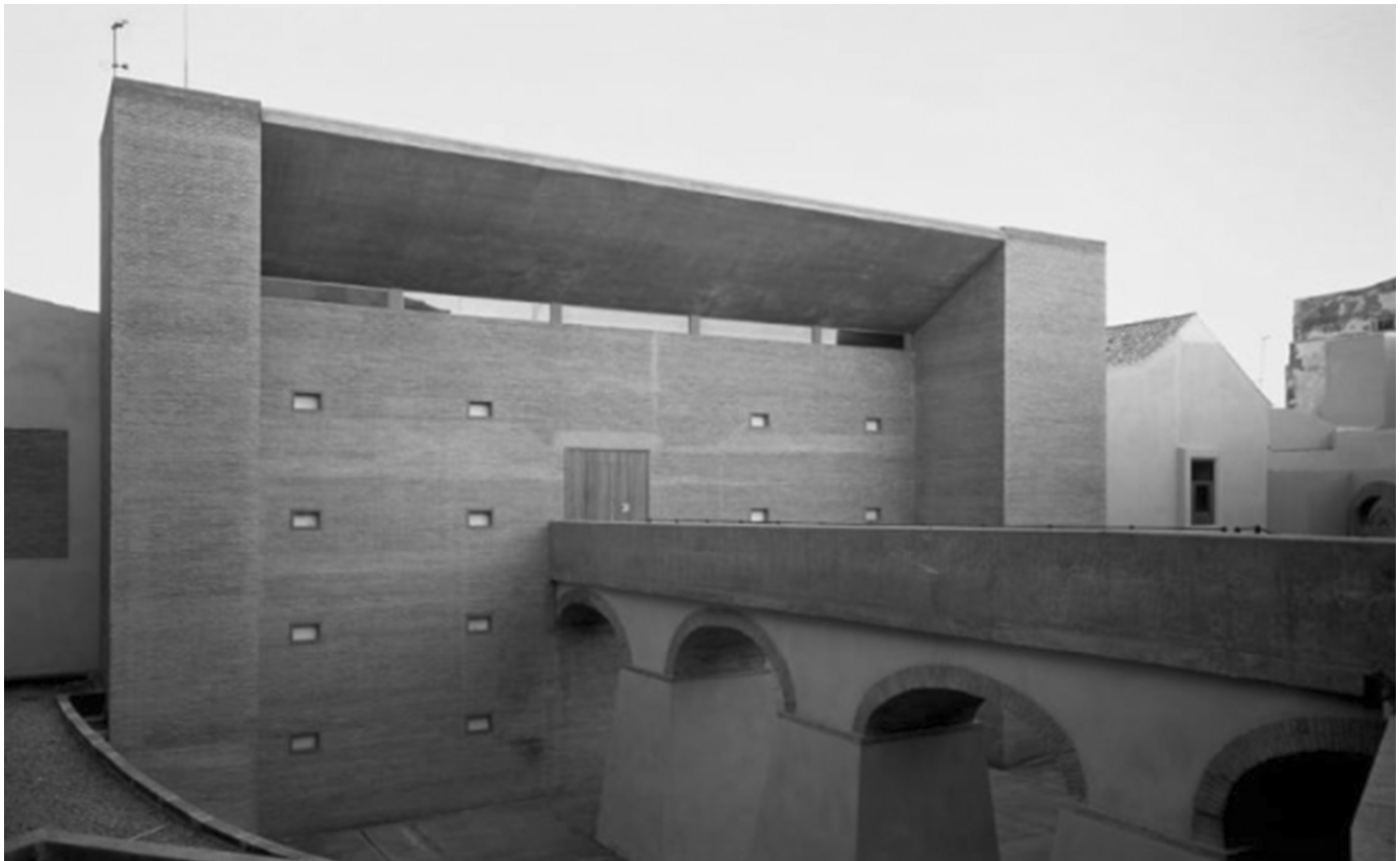
Fig. 10 - Melilla, Hospital del Rey, particolare del fronte meridionale ricostruito con mattoni pieni (da «DiseñoInterior», 1997).
