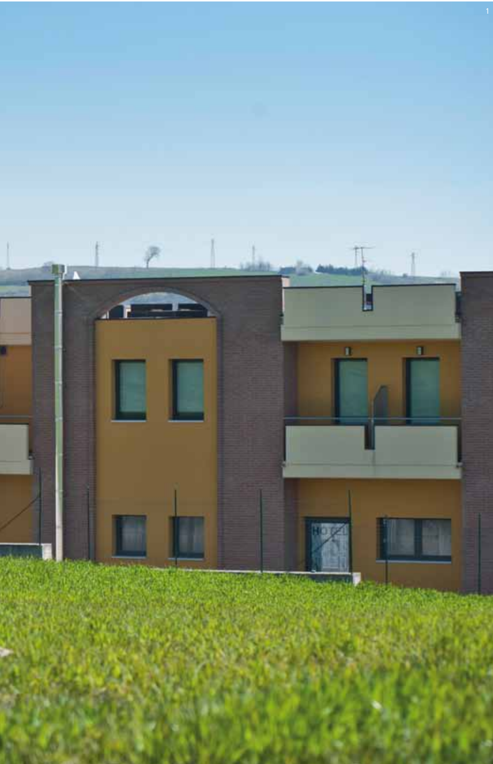
1. Vista del nuovo volume a sinistra in affaccio alla preesistenza.
