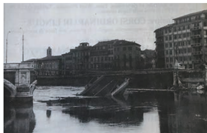
Figura 10. Foto del Ponte Solferino a Pisa prima e dopo il crollo (alluvione del novembre 1966). Supplemento del Tirreno del 6 novembre 1986.
