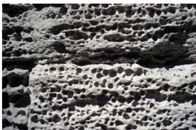
Figura 3. Alveolizzazione causata da degrado (foto di ing. Antonio Baldini, Carrara).
