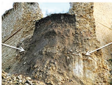
Figura 4. Il primo crollo delle mura di Magliano in Toscana. Morfologia interna resa evidente dal crollo.
