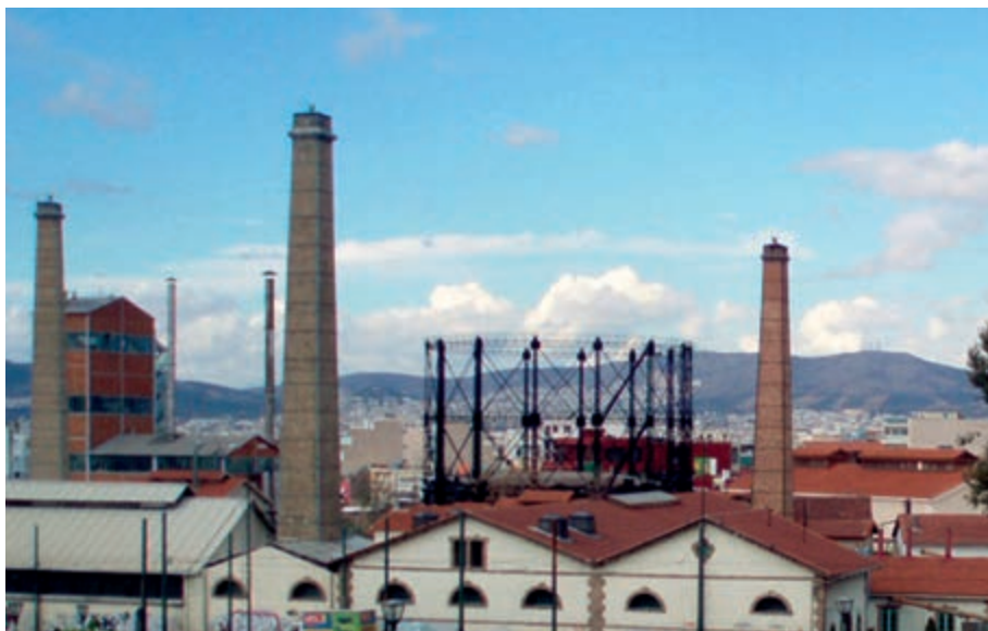
Veduta delle officine di Gàzi ad Atene.
