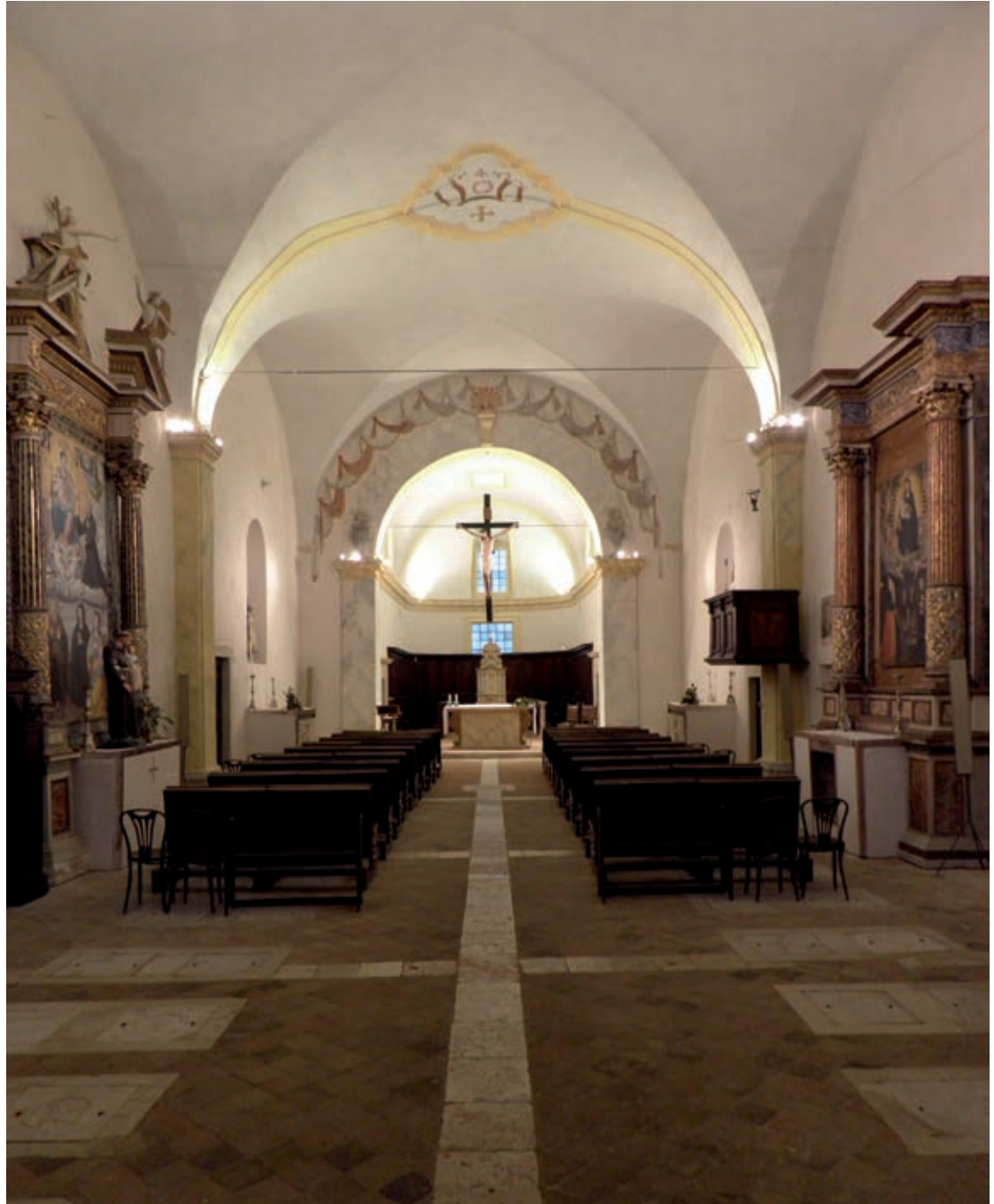
Fig.38: Interno della chiesa dopo il restauro
