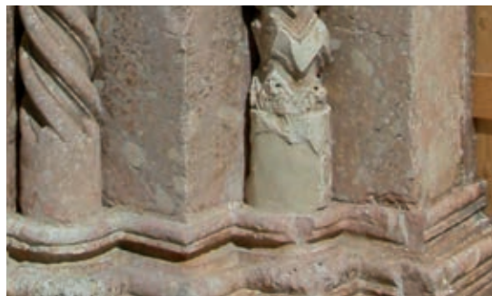
Fig. 10: Reintegrazione con impasto di resina e polvere di calcare della base della colonnina
