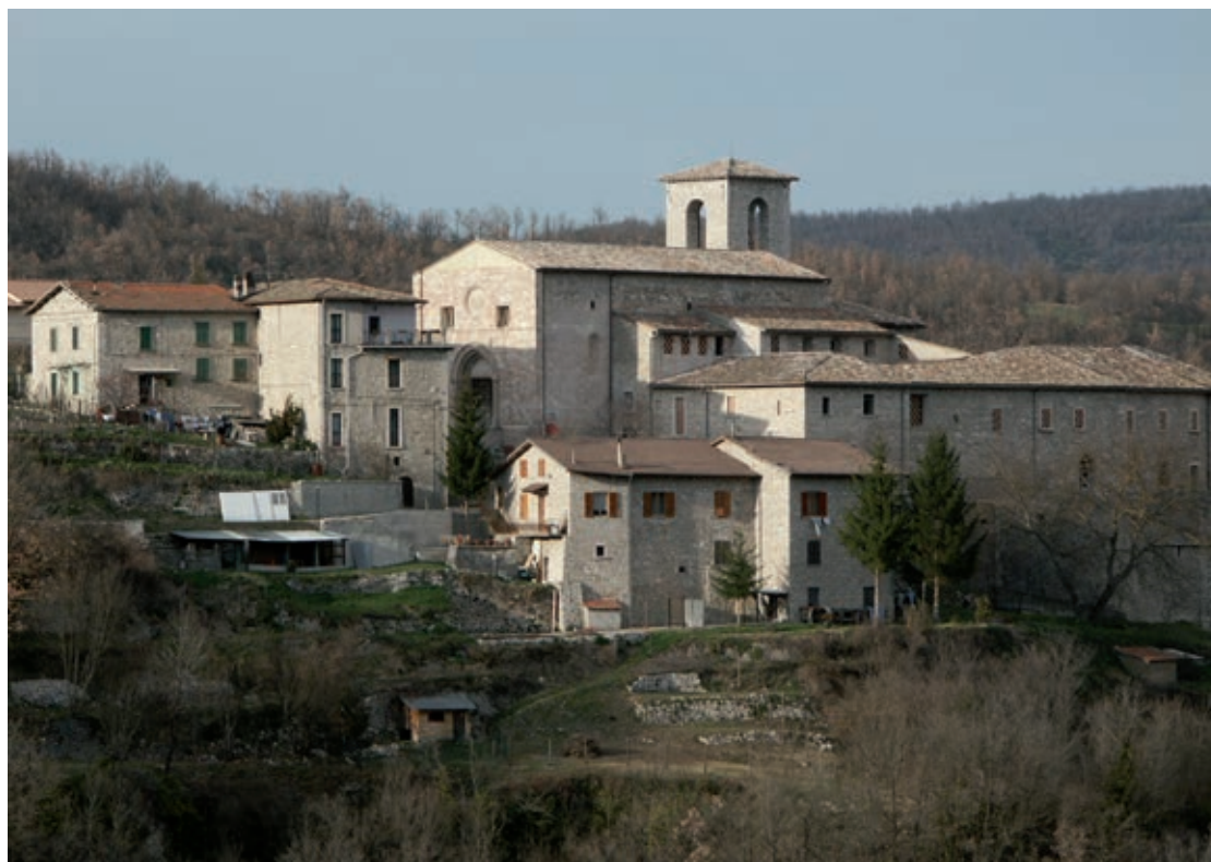
Fig. 28: Cascia, veduta della chiesa e del convento di Sant'Agostino (2008)
