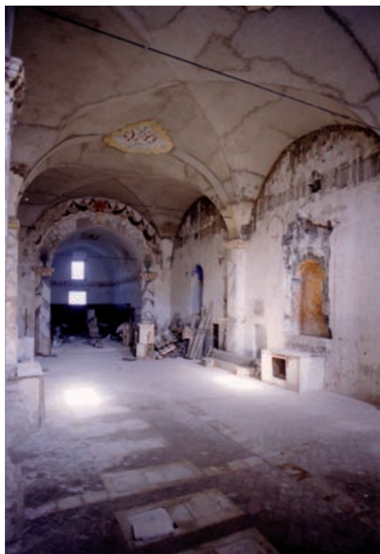
Fig. 37: L'interno della chiesa dopo l'intervento di consolidamento (2001)
