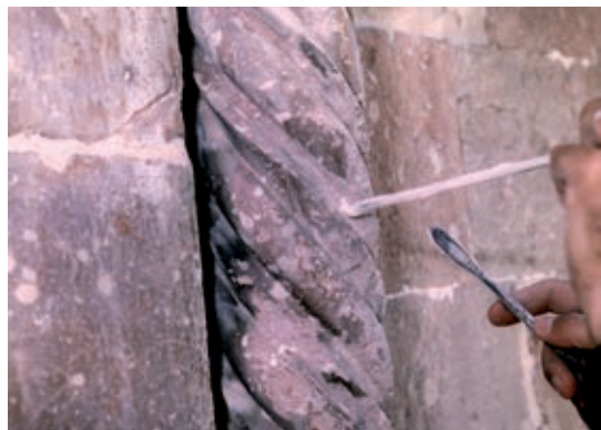
Fig. 9: Intervento di imperniatura di una delle colonnine tortili del portale
