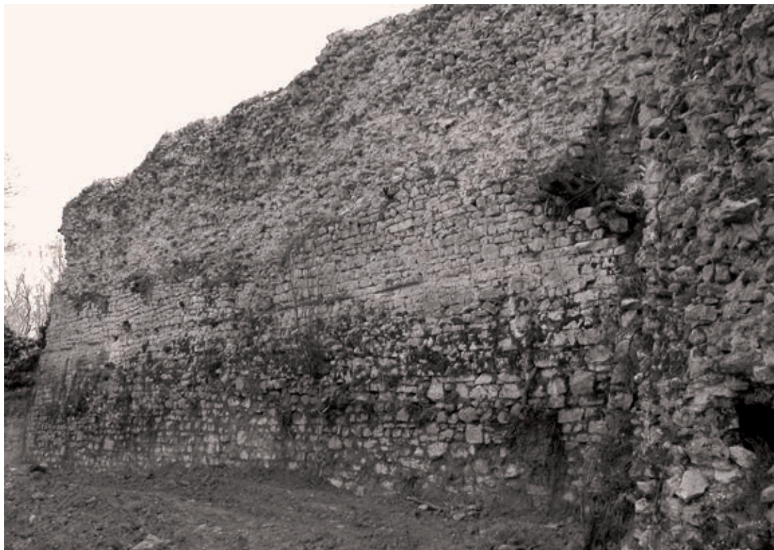
Fig.21: Cascia (Perugia), la rocca. Il fronte nord prima dell'intervento di restauro (2003).
