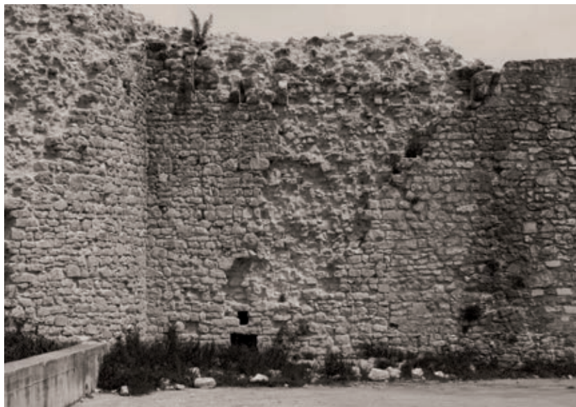
Fig. 17: Cascia (Perugia), la rocca. Particolare dell'apparecchio murario ovest prima del restauro (2003).
