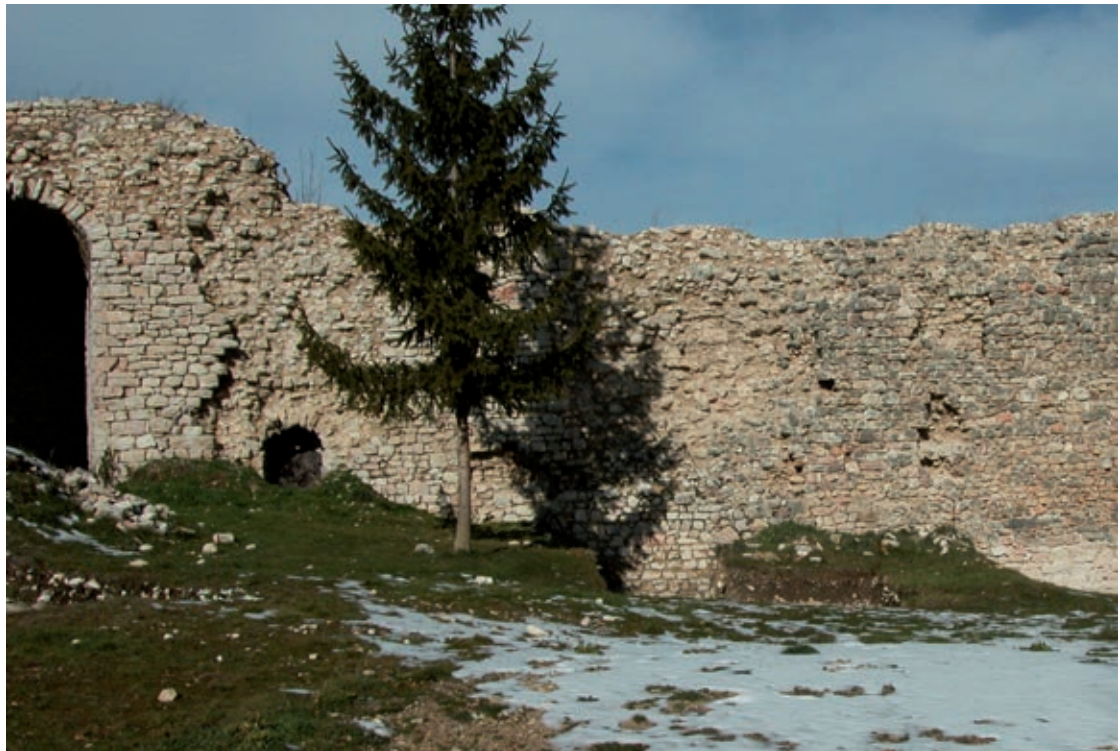
Fig. 23: Cascia (Perugia), la rocca. L'apparecchio murario del fronte interno nord prima del restauro (2003).
