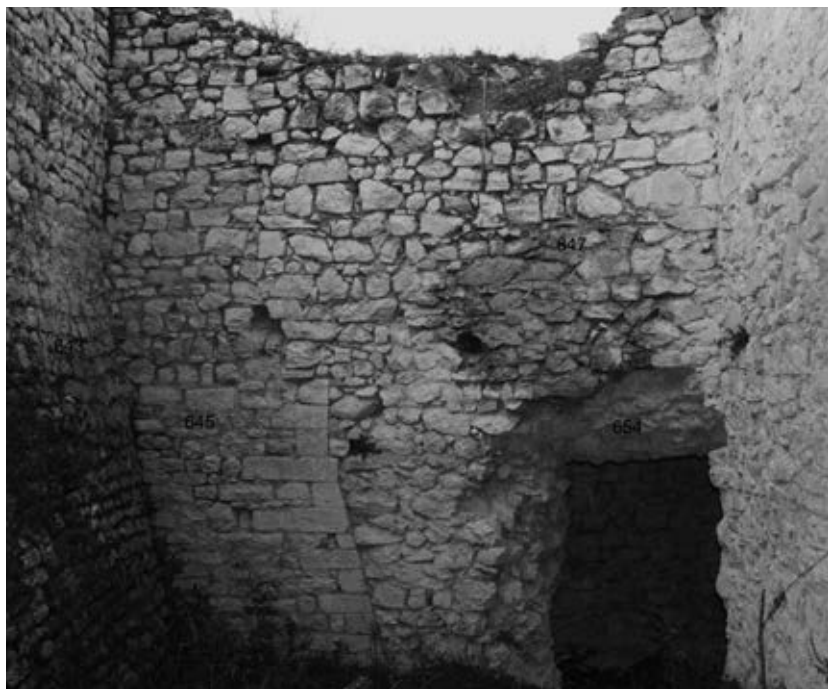
Fig. 14: Resti del muro perimetrale est della rocca
