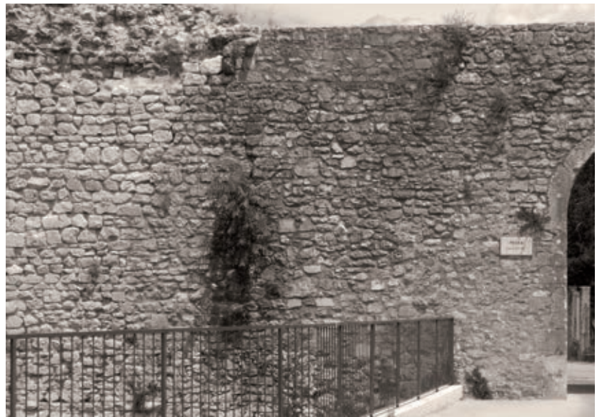
Fig. 18: Cascia (Perugia), la rocca. Particolare dell'apparecchio murario ovest dopo il restauro (2005).
