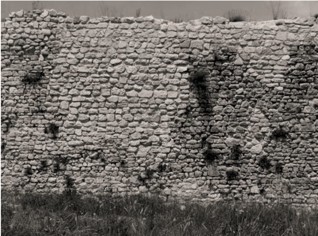
Fig. 16: Cascia (Perugia), la rocca. L'apparecchio murario del fronte interno nord.
