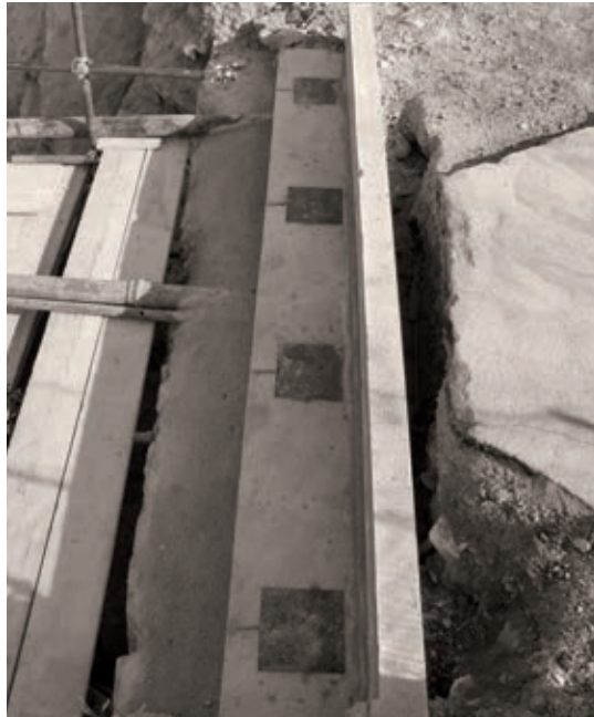
Fig. 28: Cascia (Perugia), la rocca. Particolare dell'appoggio in calcestruzzo armato del passaggio carrabile.
