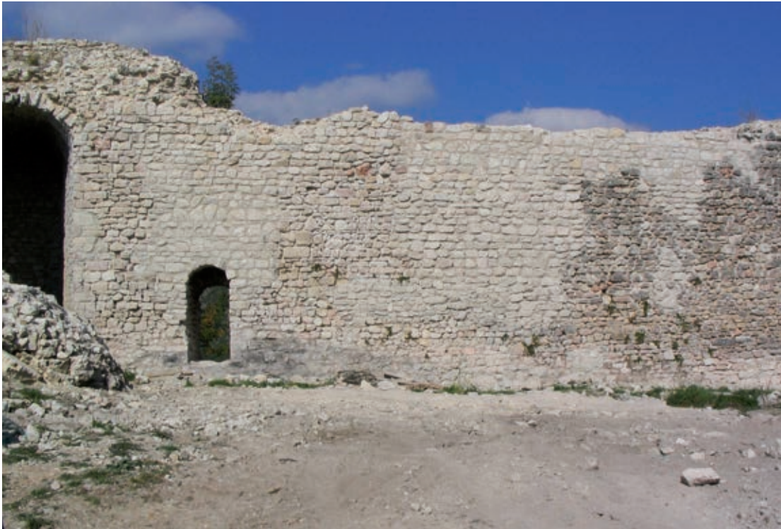
Fig. 24: Cascia (Perugia), la rocca. L'apparecchio murario del fronte interno nord dopo l'intervento di restauro (2005).
