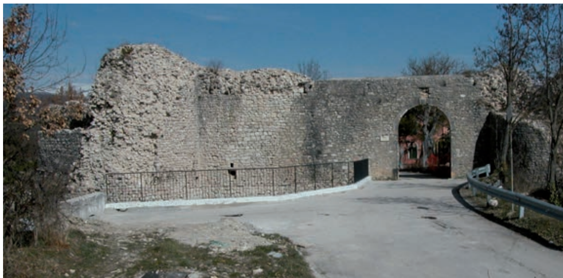
Fig. 20: Cascia (Perugia), la rocca. Veduta del fronte ovest dopo l'intervento di restauro (2005).
