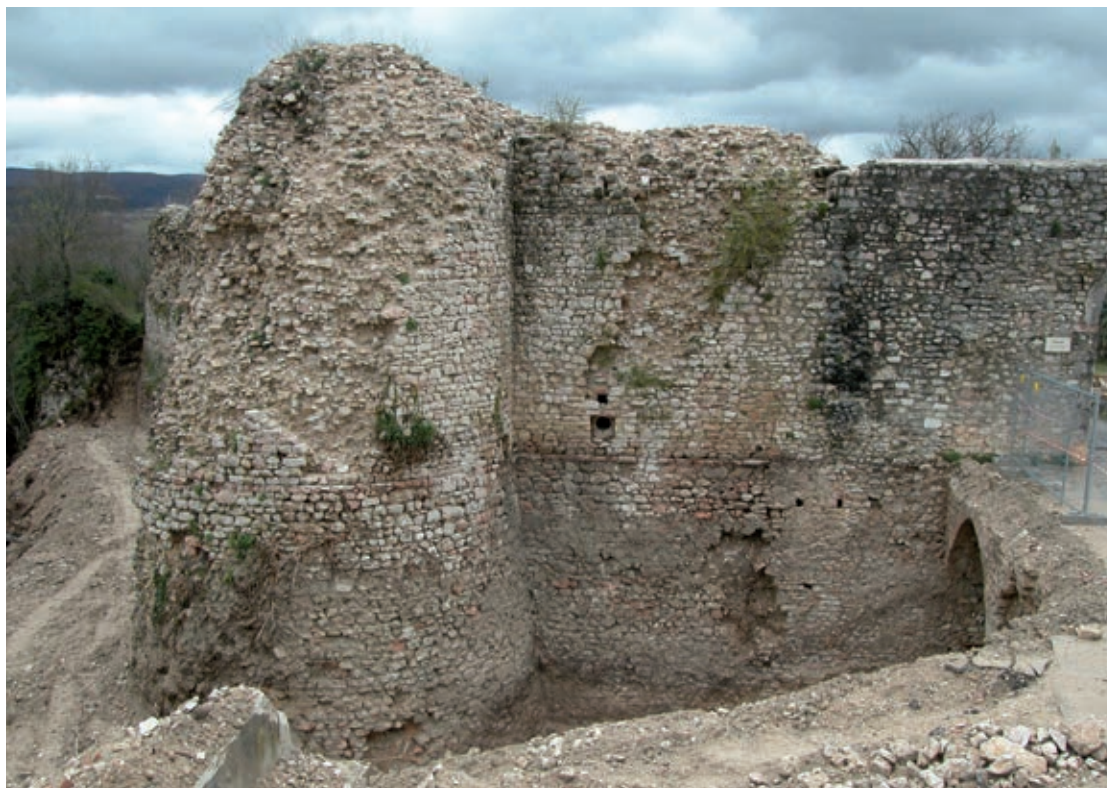
Fig. 19: Cascia (Perugia), la rocca. Il fronte sud durante le opere di sterro (2003).
