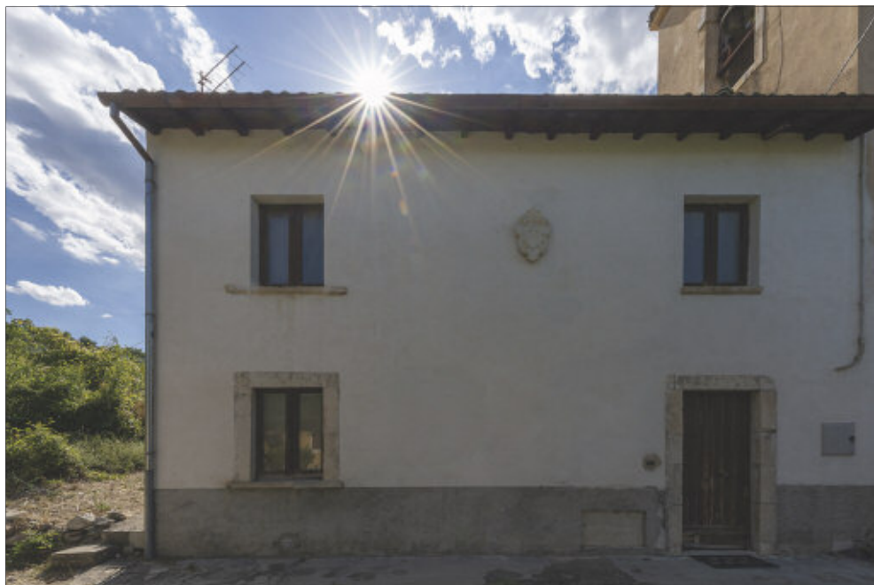
Fig. 18 – Bugnara, complesso della Madonna della Neve, facciata della casa canonica (foto Luca Del Monaco)
