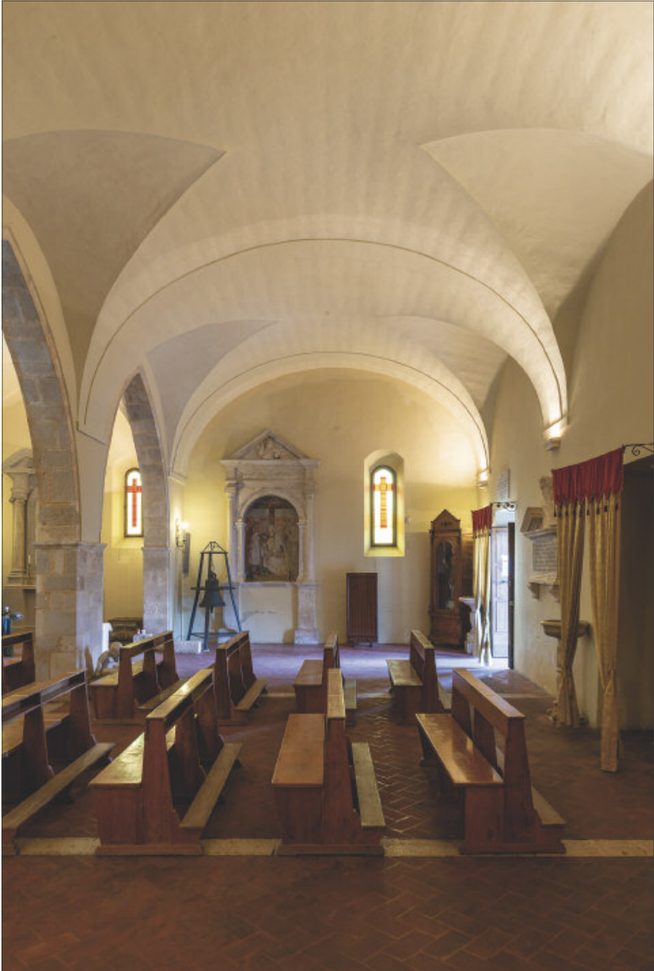
Fig. 27 – Bugnara, chiesa della Madonna della Neve, primo ambiente trasversale coperto da volta a botte unghiata (foto Luca Del Monaco)
