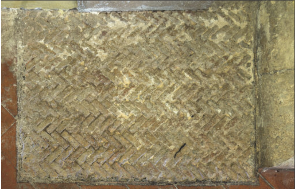
Fig. 4 – Bugnara, chiesa della Madonna della Neve, resto di pavimentazione romana nella cappella della Madonna di Loreto (foto Luca Del Monaco)
