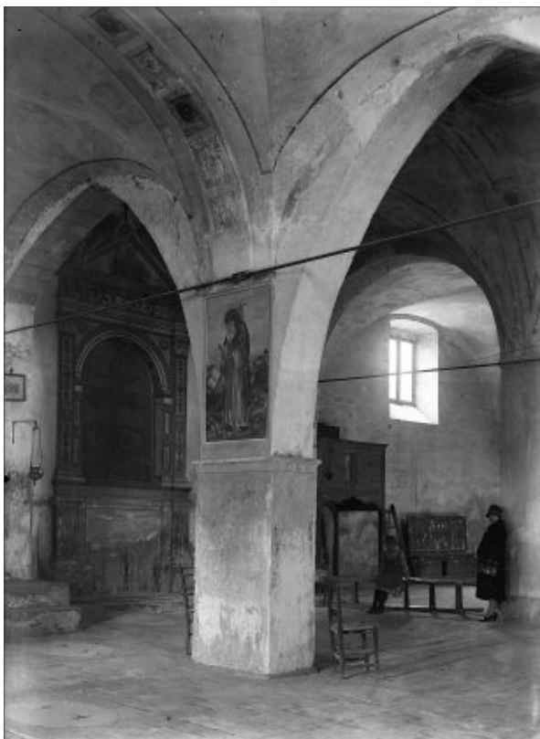
Fig. 40 – Bugnara, chiesa della Madonna della Neve, veduta d'epoca dell'interno: il primo pilastro a sinistra (foto Archivio Piccirilli)
