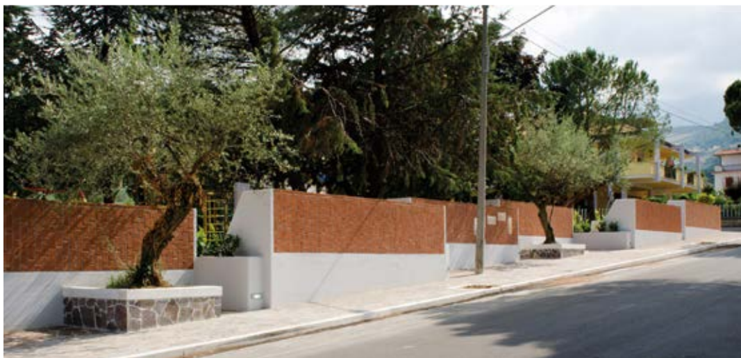
Federico Bilò GAP AA , Riqualficazione area a verde attrezzato in via Felsani e realizzazione di percorso vita/palestra all'aperto, Civitella Casanova (PE), 2010/12.
