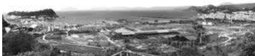
Figura 1. Quartiere Bagnoli, Napoli. Fonte: foto di Federica Montalto (2019).
