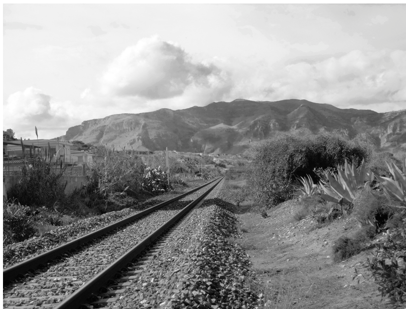
Figura 1. Tratto ferroviario che attraversa la zona Aleccia/Calatubo, Alcamo Marina (TP). Fonte: foto di Lia Fedele (2017).
