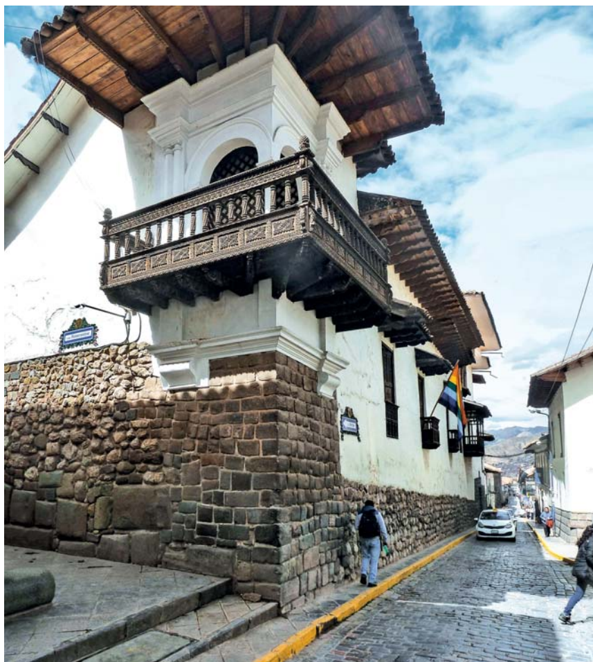
5/ Edificio coloniale ricostruito dopo il sisma del 1650 (foto dell'A. 2018).
