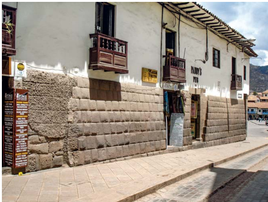
4/ Edificio coloniale con muratura in adobe costruita sopra le antiche pareti in pietra incaiche (foto dell'A. 2018).
