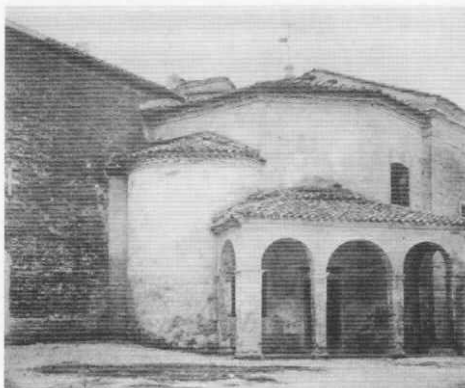
Battistero degli ariani, abside della chiesa di Santa Maira in cosmedin, isolato con i restauri del 1915-1918 da G. Gerola, il portico del XVII secolo fu demolito nel 1899 (da U. FOSCHI, G. RAVALDINI, Ravenna com'era, Ravenna 1974).
