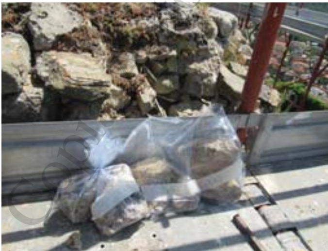
Figure 92-94 – Colle Sant'Angelo di Carsoli, torre principale: prelievo dei campioni di malta e rimozione degli elementi decorati successivamente rimontati previa numerazione (foto S. Cecamore, 2019).
