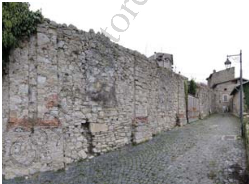
Figura 22 – Murature d'ambito di un fabbricato ottocentesco costruito sui resti del monastero di Sant'Angelo in Carseolis (foto S. Cecamore, 2010);
