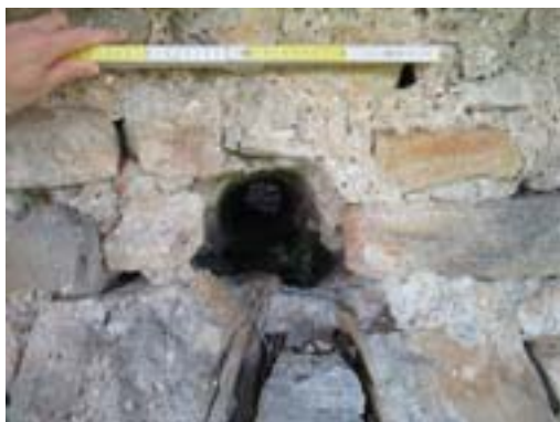
Figure 87-88 – Colle Sant'Angelo di Carsoli, torre principale: presenza di alloggiamenti e fori passanti per legamenti lignei o l'ancoraggio di strutture in aggetto (foto S. Cecamore, 2019).
