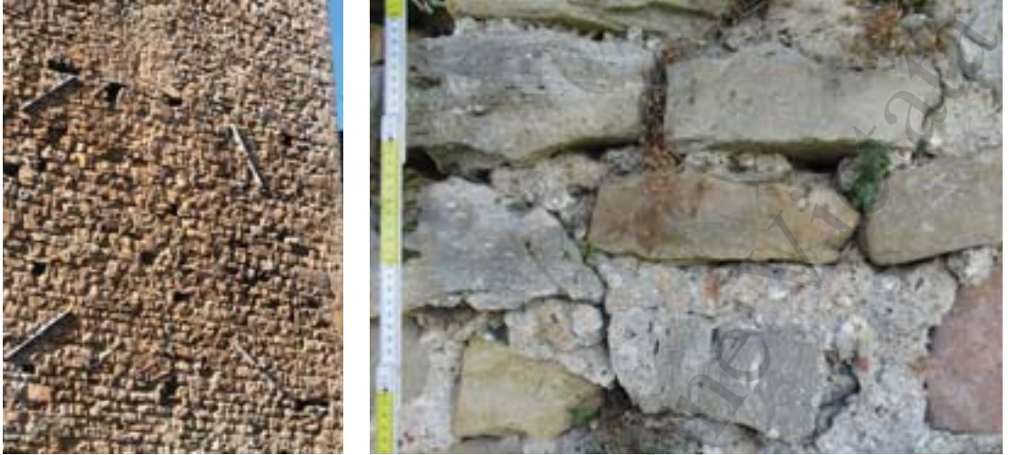
Figura 91 – Complesso di Colle Sant'Angelo, torre principale: consolidamento della torre principale: capo-chiave esterni della struttura metallica di consolidamento (foto S. Cecamore, 2019).
