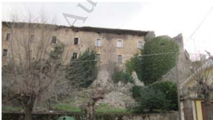
Figura 50 – Morrea (AQ), castello-palazzo Piccolomini, profili scarpati e torre angolare del castrum (foto S. Cecamore, 2010).
