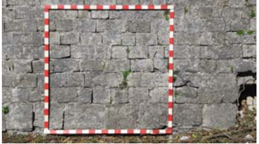
Figura 65 – Carsoli, foto del paramento in conci del profilo scarpato probabilmente giustapposto alle murature del primo nucleo fortificato (foto S. Cecamore, 2010).
