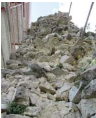
Figure 83-86 – Colle Sant'Angelo di Carsoli, torre principale: decoesione degli elementi lapidei delle creste sommitali e del nucleo murario delle porzioni crollate (foto S. Cecamore, 2019).
