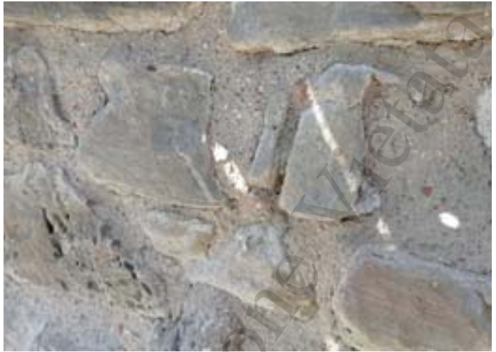
Figure 95-97 – Colle Sant'Angelo di Carsoli, torre principale: stuccatura e stilatura dei giunti attraverso leganti compatibili (foto S. Cecamore, 2019).
