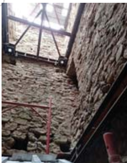
Figura 89 – Complesso di Colle Sant'Angelo, torre principale: lacuna del paramento colmata attraverso la ricomposizione dell'apparecchio murario (foto S. Cecamore, 2019).
