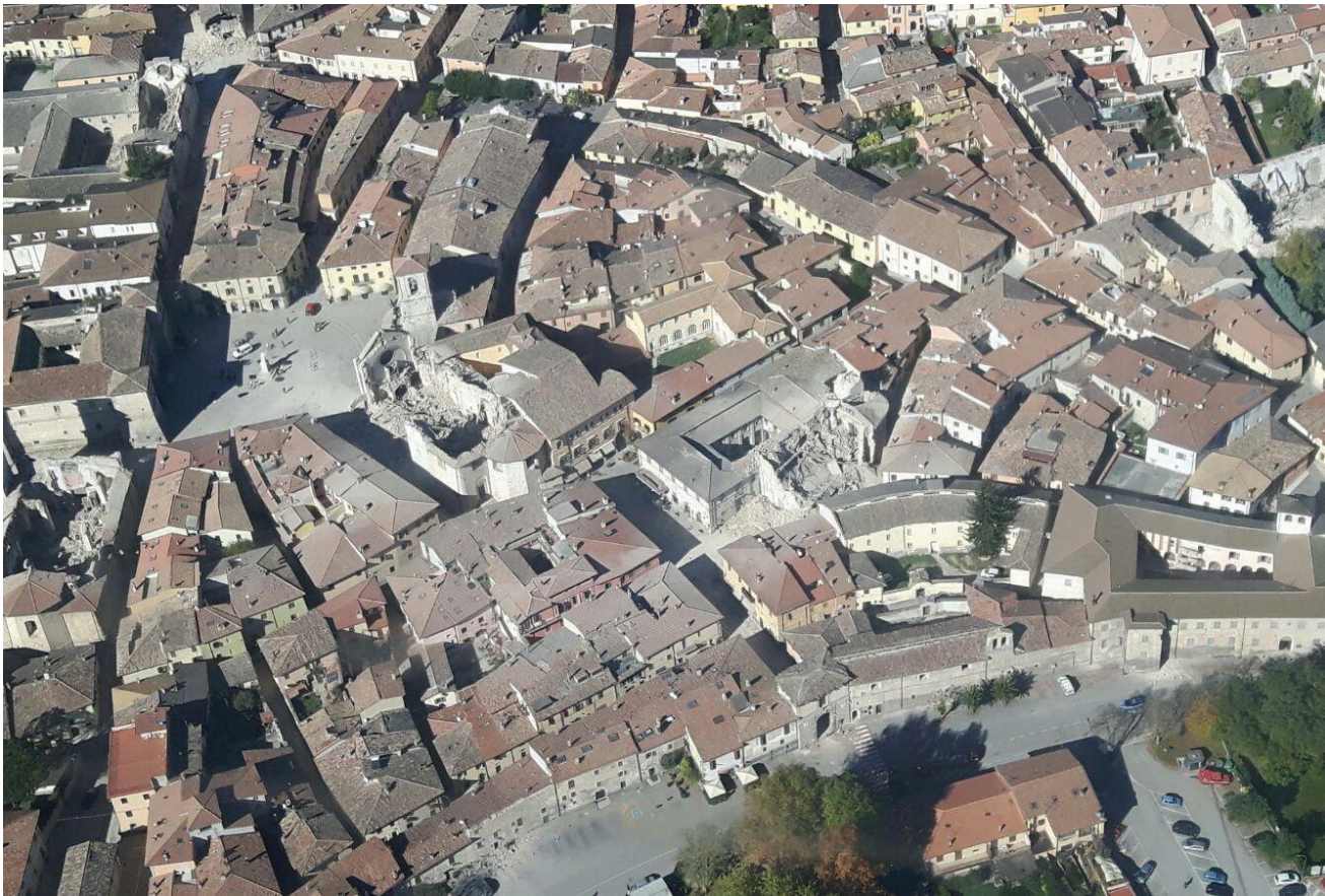
Fig 7: Relocarea satului Chiavano (Cascia) după cutremurul din 1979 / The re-location of the village of Chiavano (Cascia) after the 1979 earthquake
