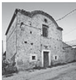
Figura 14 – Bomba (Ch), edificio a blocco di Sant'Antonio al ponte, con apparecchio murario in blocchi e bozze di arenaria.
