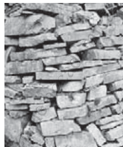
Figura 6 – Taranta Peligna (Ch), conci di calcare di vario spessore.
