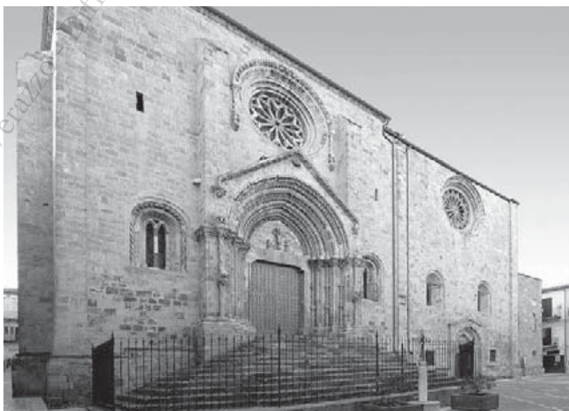
Figura 3 – Lanciano (Ch), chiesa di S. Maria Maggiore, prospetto principale.
