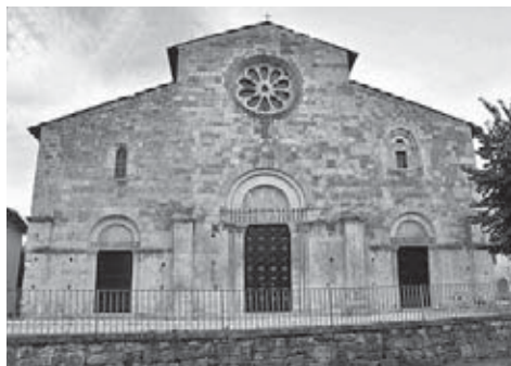
Figura 8 – Caramanico Terme (Pe), chiesa di S. Tommaso, dettaglio dell'apparecchio murario in conci di calcare.
