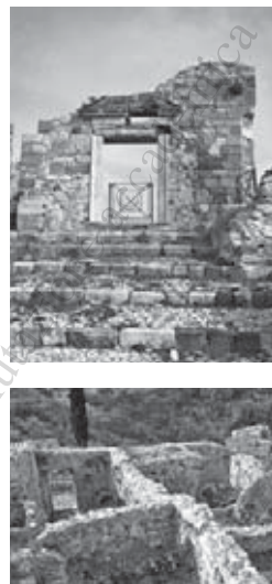
Figura 6 – Gessopalena (Ch), abbazia di S. Egidio, portale di ingresso con reintegrazione sommitale della cresta muraria.
