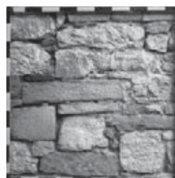
Figura 12 – Bomba (Ch), Sant'Antonio al ponte, apparecchio murario in blocchi di arenaria e ciottoli di calcare a corsi orizzontali, che tesse l'edificio padronale.
