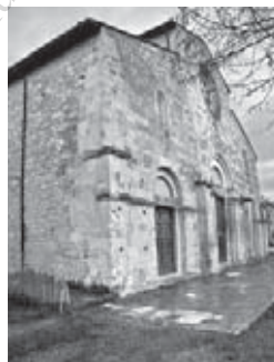
Figura 10 – Fossacesia (Ch), chiesa di S. Giovanni in Venere, prospetto principale segnato da reintegrazioni mimetiche.
