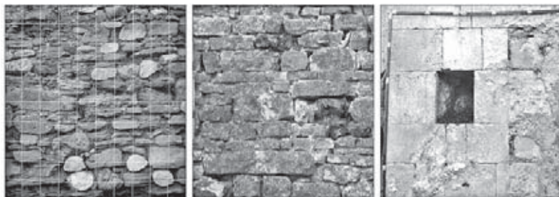
Figura 16 – Quadro sinottico degli apparecchi murari: il primo in bozze e ciottoli di fiume tesse i resti del prospetto principale della chiesa di S. Martino, Ortona (Ch), databile tra il XII e il XIII secolo; il secondo in blocchi di arenaria e calcare caratterizza il prospetto orientale della chiesa di S. Croce, Atessa (Ch), databile al XIII secolo; l’ultimo in conci di calcare contraddistingue la controfacciata della chiesa di S. Eufemia, Fara Filiorum Petri (Ch), databile al XIII secolo.
