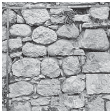
Figura 9 – Fara Filiorum Petri (Ch), chiesa di S. Eufemia, apparecchio murario in conci di pietra calcarea della controfacciata.
