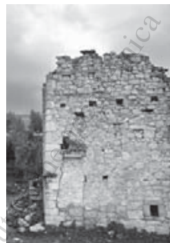
Figura 23 – Salle Vecchia (Ch), edificio ridotto a rudere in via della Croce, con apparecchio murario in blocchi e bozze lapidee, databile al XVIII secolo.
