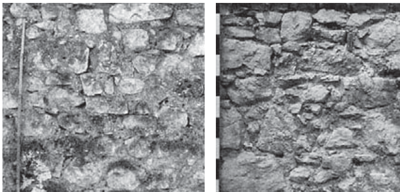
Figura 35 – Fara Filiorum Petri (Ch) , chiesa di Sant'Eufemia, apparecchio murario in bozze di calcare rilevato lungo il fronte meridionale, databile al XIII secolo.
