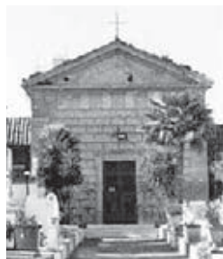
Figura 63 – Vasto (Ch), Camposanto, facciata della cappella formata da fasce di mattoni.
