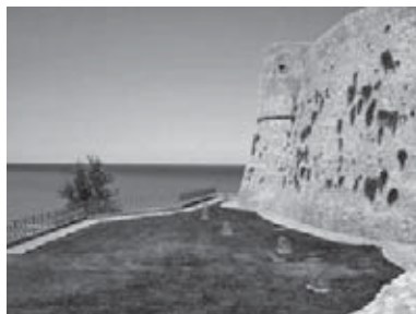
Figura 8 – Ortona (Ch), castello, intervento di restauro del 2001, segnato da una estesa reintegrazione dell'apparecchio murario.
