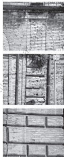
Figura 65 – Vasto (Ch), palazzo Palmieri, dettaglio delle bugne del prospetto su piazza Rossetti e lungo corso Garibaldi.
