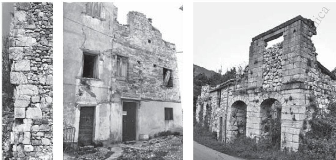
Figura 20 – Archi (Ch), castello, cantonale del fronte occidentale, caratterizzato da una perdita di coesione dei componenti lapidei.
