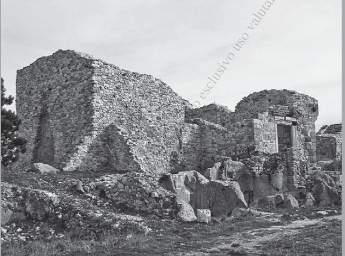
Gessopalena (Ch), chiesa di S. Egidio, prospetto meridionale.
