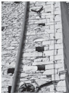
Figura 49 – Casoli (Ch), edificio su Largo Scalelle, n. 14, particolare della muratura di facciata, con l’individuazione di elementi di reimpiego.
