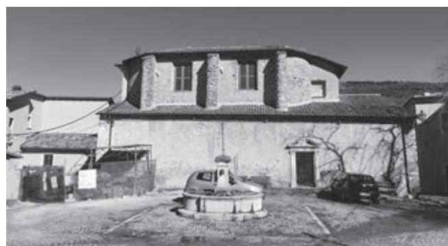
Fig. 12. Campana, chiesa di S. Giovanni, foto stato attuale del prospetto ovest.
