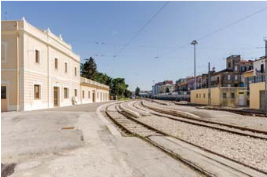
Fig. 61. Ferrovia Sangritana. Stazione dismessa di Lanciano (CH).
