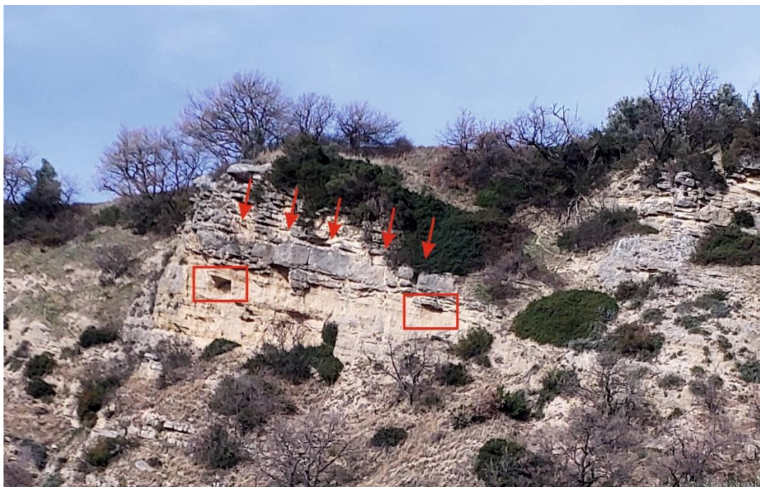
Figura 251. Versante a direzione circa est-ovest nel settore meridionale della Rupe di Turrivalignani. I riquadri rossi indicano nicchie di distacco; le frecce rosse indicano un livello di spessore metrico, costituito da un litotipo meno erodibile rispetto a quelli sottostanti, localmente aggettante per mancanza di un confinamento inferiore (quota scatto 255 m s.l.m.). Foto scattata verso nord-ovest.
