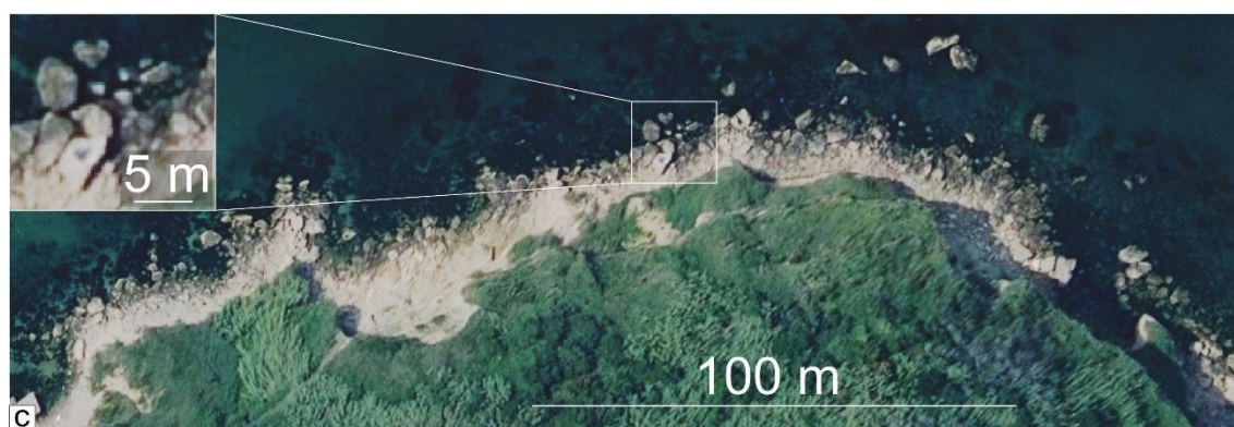
Figura 247. Ortofoto del settore a nord di località Torre Mucchia, in cui è facilmente distinguibile il deposito di frana da crollo costituito da blocchi di dimensioni metriche o plurimetriche.
