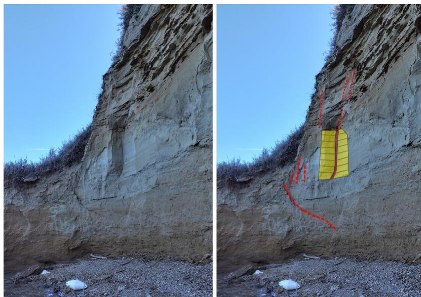
Figura 187. Parete sub-verticale a direzione circa N045O localizzata nel settore occidentale dell'area di studio, a nord-est di località Torre Mucchia (0 m s.l.m.). Nella parte alta del versante si rileva un sistema di fratture sub-verticali parallele alla parete e immergenti di circa 80° verso nord-est (indicate dalla linea a tratteggio rossa nella figura di destra); questi sistemi intersecano localmente discontinuità oblique rispetto alla parete, isolando blocchi rocciosi che franano sotto la spinta della forza di gravità. In giallo è indicata una nicchia di distacco derivante da tale intersezione. Foto scattata verso sud-est.
