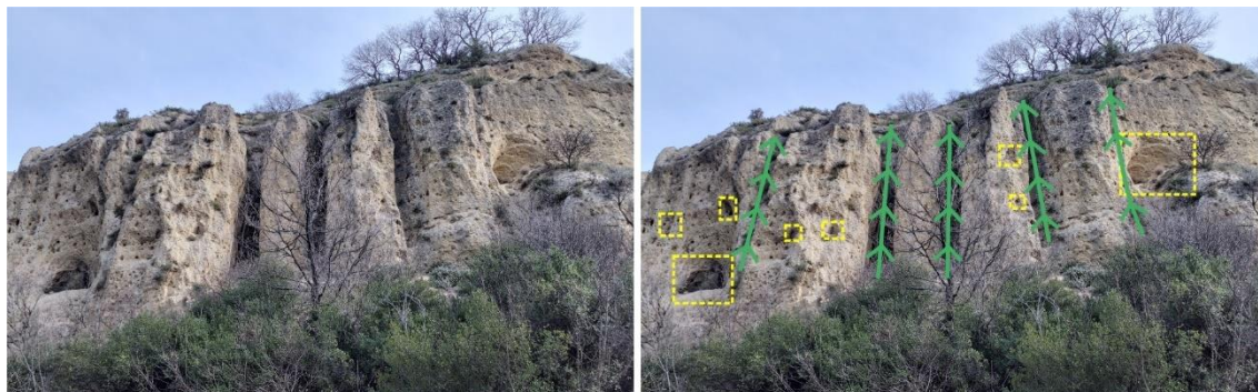
Figura 176. Parete sub-verticale con direzione circa nord-sud nel settore meridionale dell'area di studio. Il litotipo conglomeratico è profondamente inciso, con solchi di erosione anch'essi sub-verticali (indicati dalla simbologia in verde nell'immagine di destra). Si nota, inoltre, la presenza di numerose cavità di dimensioni da decimetriche a metriche (riquadri gialli nell'immagine di destra; 265 m s.l.m.). Foto scattata verso nord-est.
