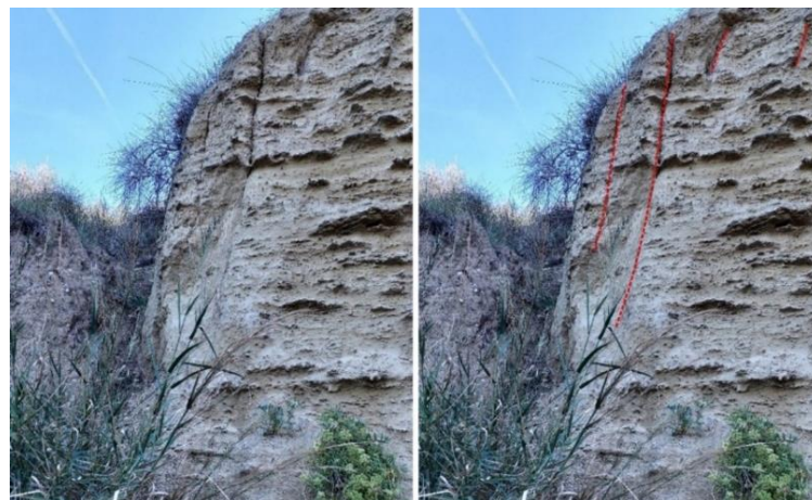
Figura 185. Sperone roccioso nel settore centro-occidentale dell'area di studio, a nord di località Torre Mucchia; la forma si imposta all'intersezione tra due pareti sub-verticali con direzione circa N030E e N090 (0 m s.l.m.). Presente sistema di fratture con direzione N070O da sub-verticali ad immergenti verso nord con angolo di circa 80° (indicate dalla linea a tratteggio rossa nella figura di destra). Le fratture si presentano da serrate ad aperte, con apertura massima di circa 1 cm, spaziate di 30-40 cm. Foto scattata verso est.
