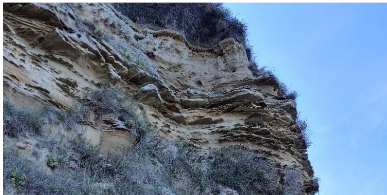
Figura 188. Versante a nord-est di località Torre Mucchia. Dettaglio di strati arenacei tabulari aggettanti (quota scatto 0 m s.l.m.). Foto scattata verso ovest.
