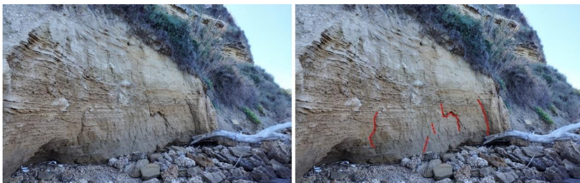
Figura 189. Parete sub-verticale a direzione est-ovest nel settore orientale dell'area di studio, a nord di località Torre Mucchia (0 m s.l.m.). Si nota la presenza di un solco di battente inattivo. Si individua inoltre una famiglia di fratture serrate a direzione est-ovest sub-verticali, con spaziatura decimetrica (indicata dalla linea a tratteggio rossa nella figura di destra). Foto scattata verso sud-ovest.
