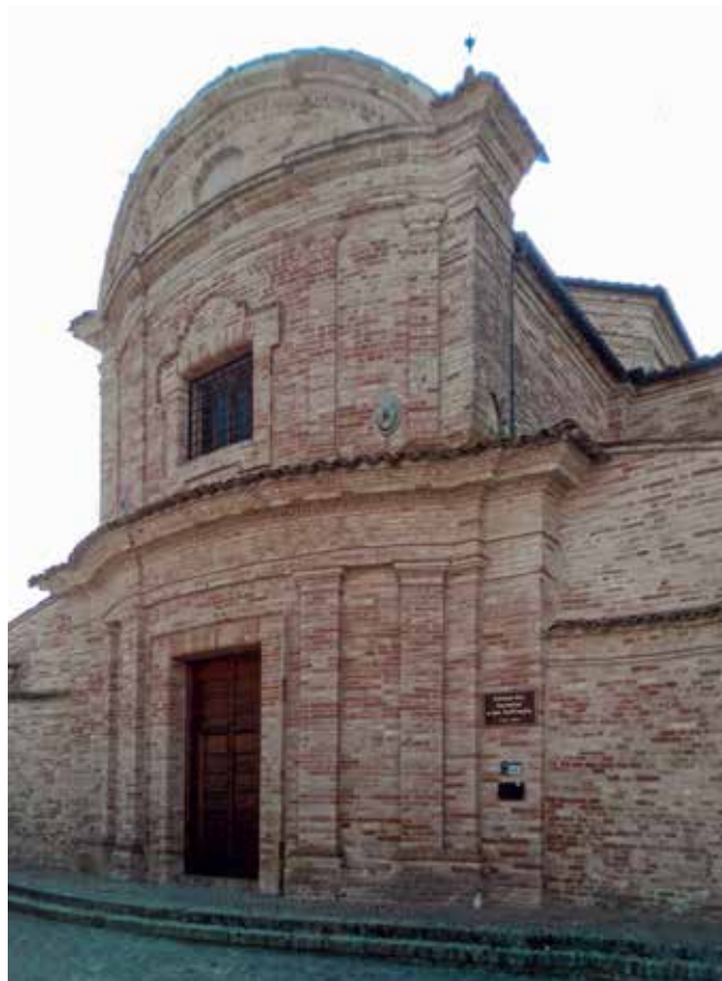
Ortezzano (FM). Chiesa del Carmine, facciata.
