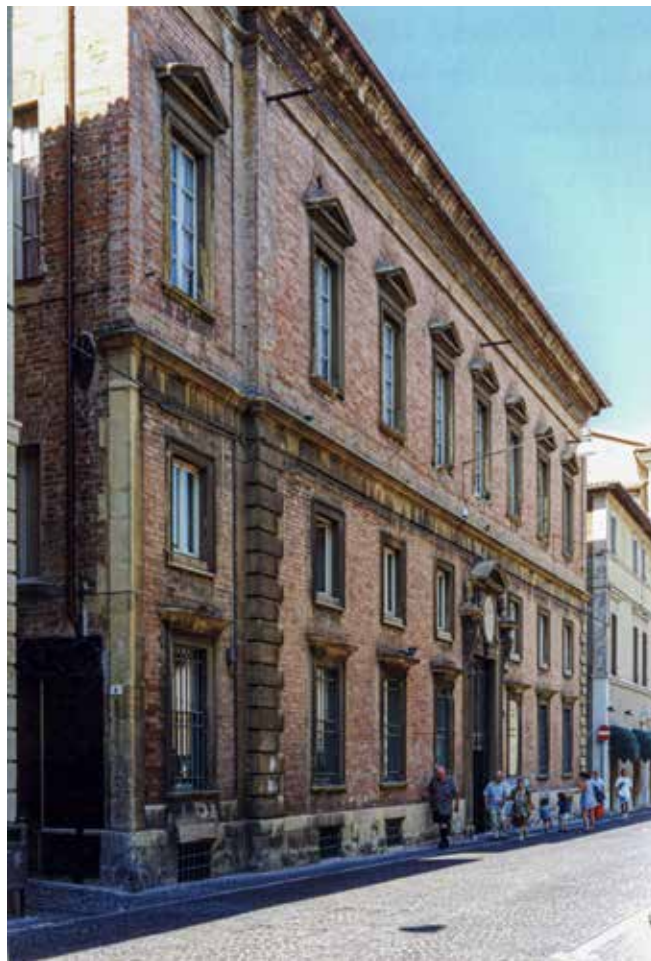
Pesaro (PU). Palazzo del Seminario, facciata (prima del restauro).
