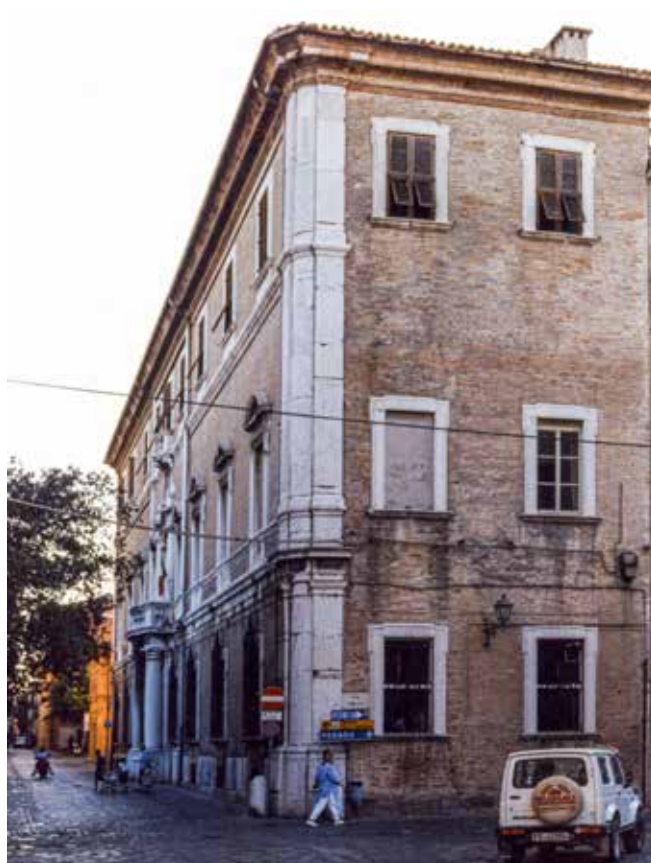
Fano (PU). Palazzo Montecchbio, prospetto.
