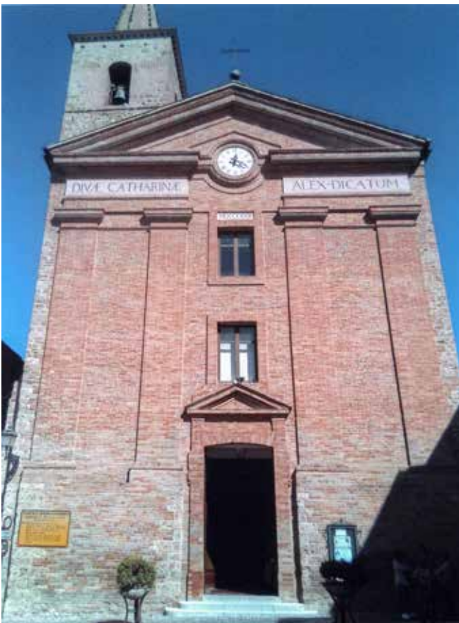
Comunanza (AP). Chiesa di S. Caterina, facciata.
