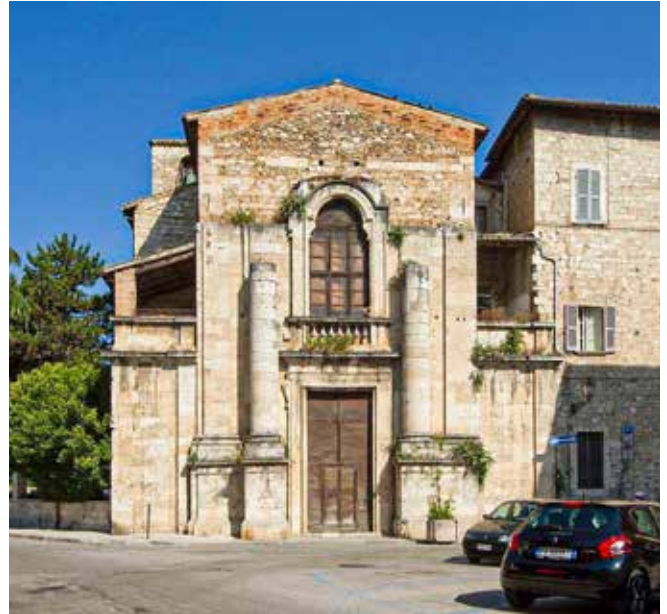
Ascoli Piceno. Chiesa dell'Angelo Custode, facciata.
