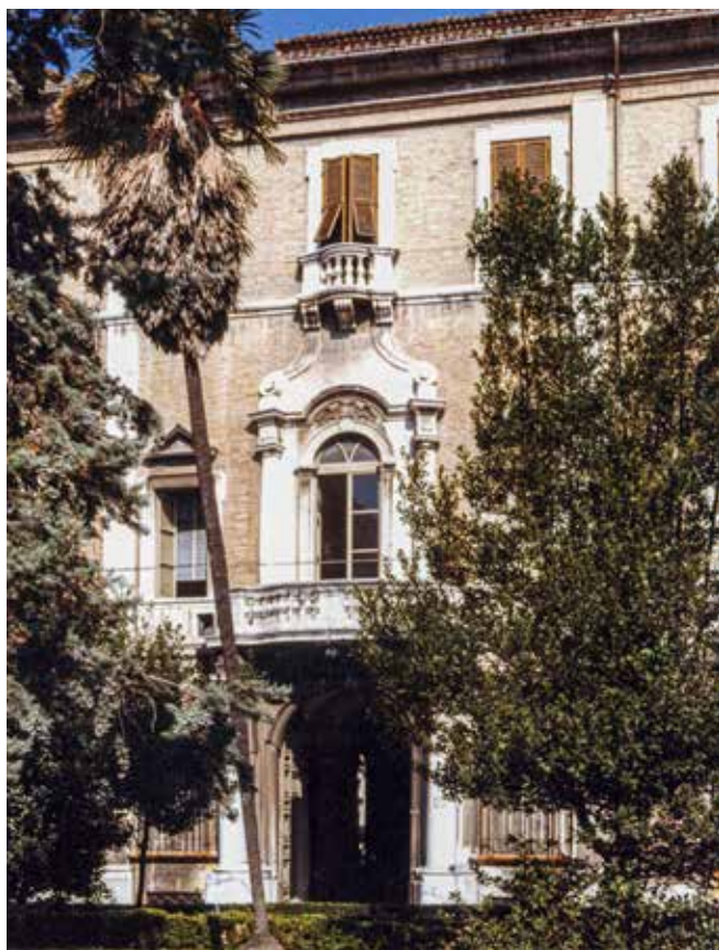
Fano (PU). Palazzo Montecchbio, facciata.
