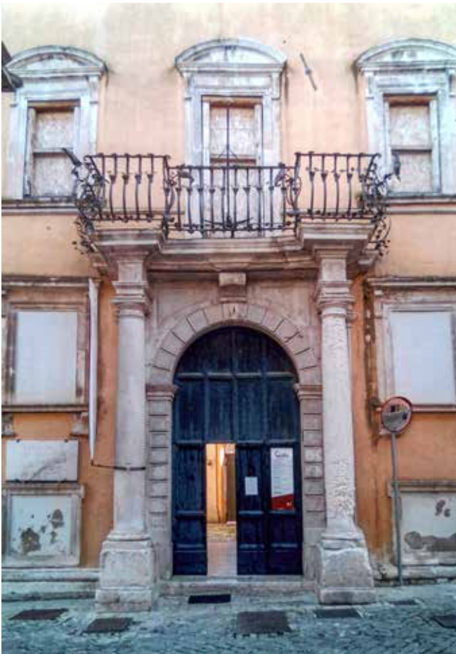
S. Severino Marche (MC). Palazzo Servanzi, facciata.
