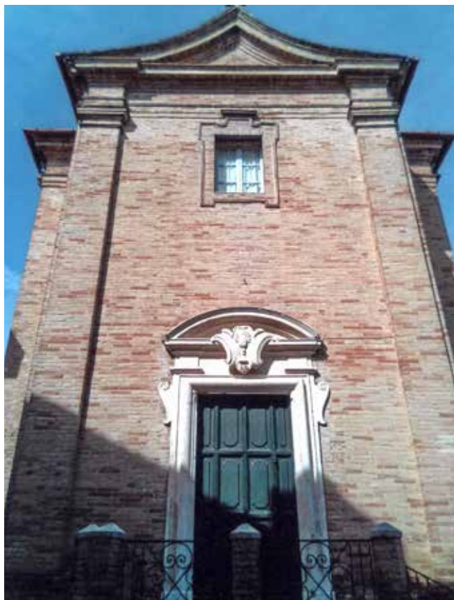
Mogliano (MC). Chiesa di S. Nicolò, facciata.
