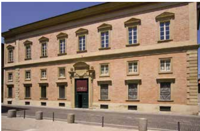
Pesaro (PU). Palazzo del Seminario, facciata.
