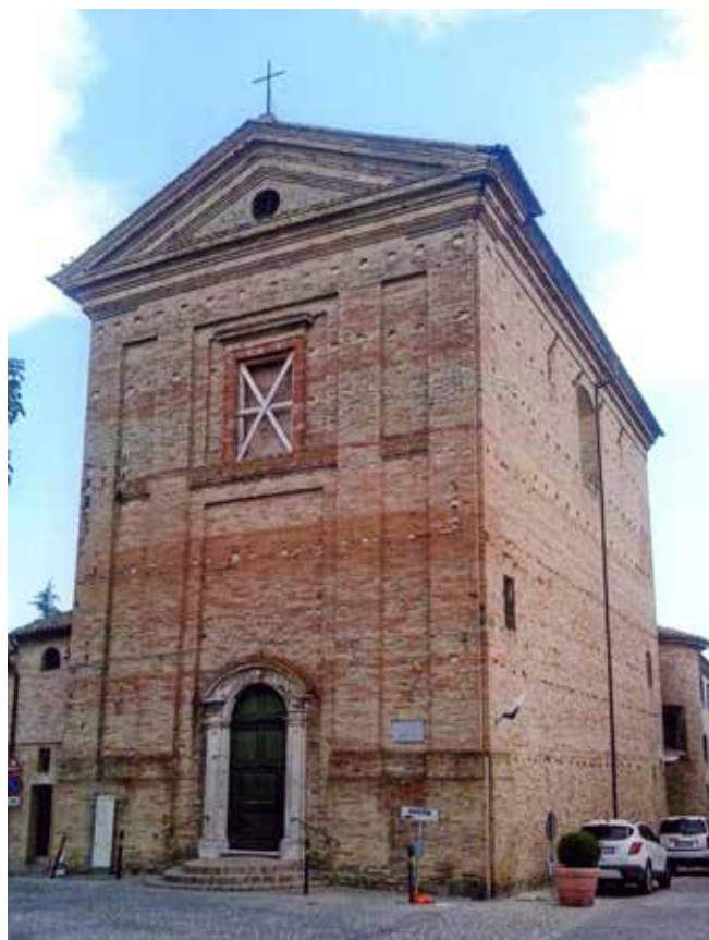
Montelupone (MC). Chiesa di S. Chiara, facciata.
