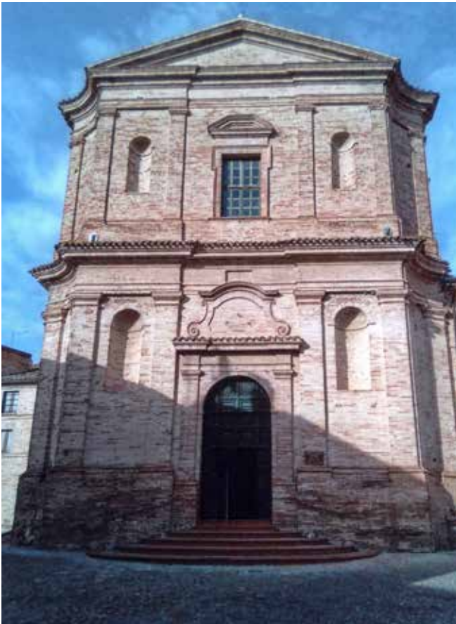
Monte Giberto (FM). Chiesa di S. Nicolò, facciata.
