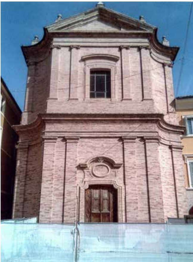
S. Severino Marche (MC). Chiesa di S. Giuseppe, facciata.
