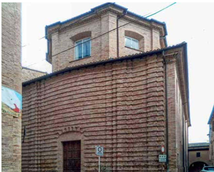
Cupramontana (AN). Chiesa di S. Caterina, facciata.
