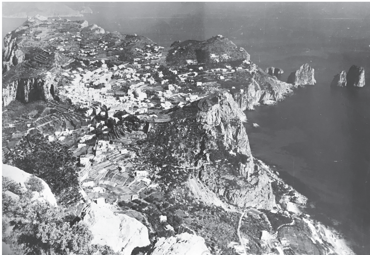
Fig. 2 - Capri, Nuova Strada del Castiglione, 1939 (ACS, Ministero della Pubblica Istruzione, Direzione generale antichità e belle arti (1852-1975), Divisione II (1940-45), Bellezze naturali, b. 30).
