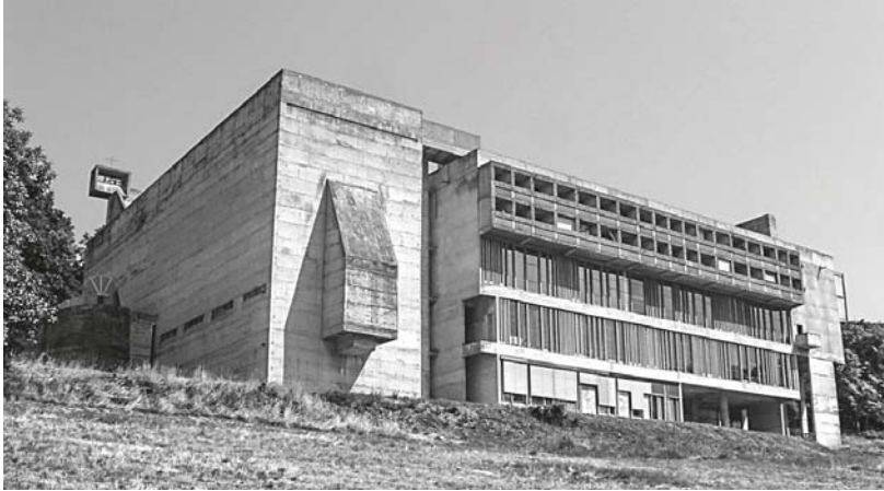
Figura 19 – Monastero di Sainte-Marie-de-La Tourette a L'Arbresle, nel Comune di Éveux (dal 1954), facciata ovest.
