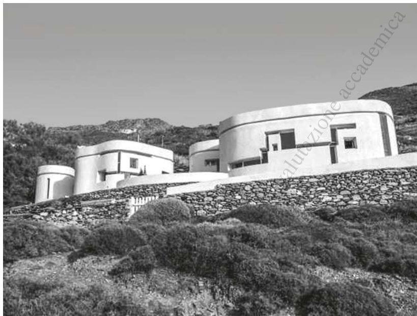
Figura 58 – Iannis Xenakis, foto della casa per vacanze di François Bernard Mâche ad Amorgos (1967), facciate da nord ovest.
