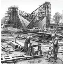
Figura 24 – Veduta del cantiere del Padiglione Philips (estate 1957), montaggio dei pannelli prefabbricati.
