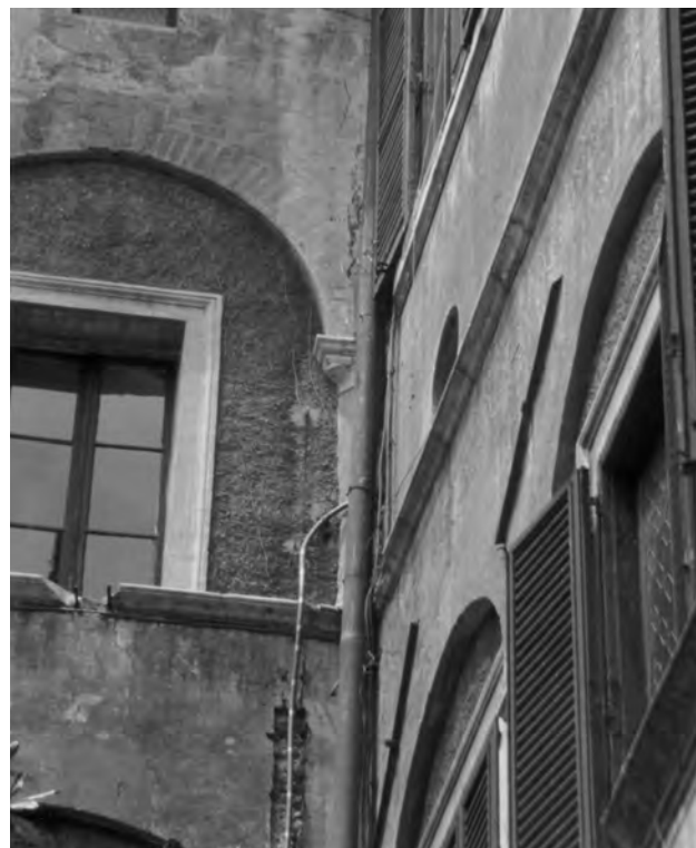
Fig.32 - Palazzo Sforza Cesarini, prospetto su via Sforza. Si nota la netta soluzione di continuità fra la fabbrica settecentesca e l'intervento piacentiniano (foto 2008).
