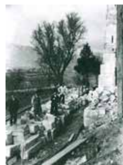
Figura 39 – Esterno della chiesa di San Pietro ad Alba Fucens dopo il sisma del 1915, alcuni tratti delle murature perimetrali cedono, così come l'abside (Archivio fotografico SBAP dell'Abruzzo)
