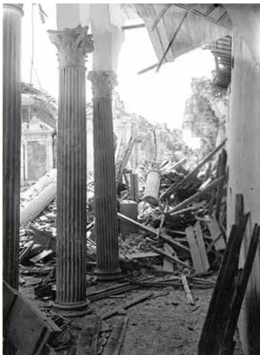
Figura 37 – Interno della chiesa di S. Pietro ad Alba Fucens dopo il sisma del 1915. Numerose colonne corinzie della navata e alcuni tratti delle murature perimetrali cedono, danneggiando irreparabilmente l'altare barocco (Archivio fotografico SBAP dell'Abruzzo)
