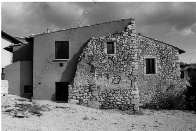
Figura 15 – Albe Vecchia (Aq). Un esempio di ricostruzione degli edifici ridotti a rudere, che giocano sul contrasto tra le antiche murature e i nuovi inserti (foto C. Varagnoli, 2006)
