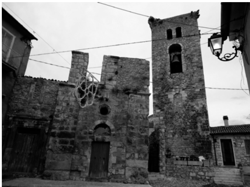
Figura 35 – Cocullo (Aq), chiesa di San Nicola, prospetto principale realizzato con filari di conci calcarei ben lavorati e posti in opera a corsi orizzontali
