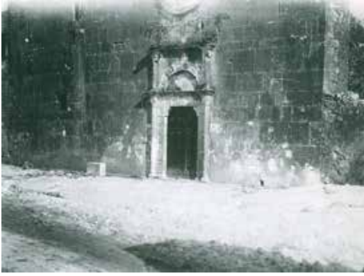
Figura 34 – La facciata della chiesa di Santa Maria a Vico di Avezzano (Aq) dopo il sisma del 1915 (Archivio fotografico SBAP dell'Abruzzo)
