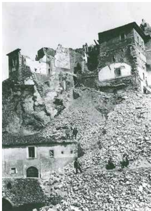
Figura 1 – Le condizioni della casa Mazzarino a Pescina (Aq) dopo il sisma del 1915, (Archivio fotografico SBAP dell'Abruzzo)
