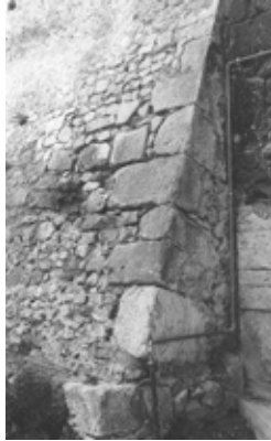
Figura 10 – Castelvecchio Subequo (Aq), case mura del centro antico con muri a scarpa impiegati per aumentare la sezione resistente del muro
