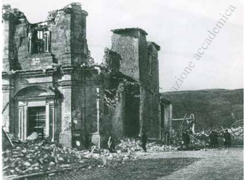
Figura 19 – Avezzano (Aq), le condizioni della chiesa di San Francesco dopo il sisma del 1915 (Archivio fotografico SBAP dell'Abruzzo)
