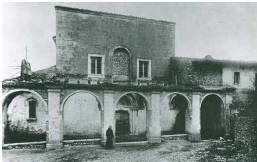
Figura 29 – La facciata della chiesa Santa Maria in Valleverde presso Celano (Aq) dopo il sisma del 1915 (Archivio fotografico SBAP dell'Abruzzo)
