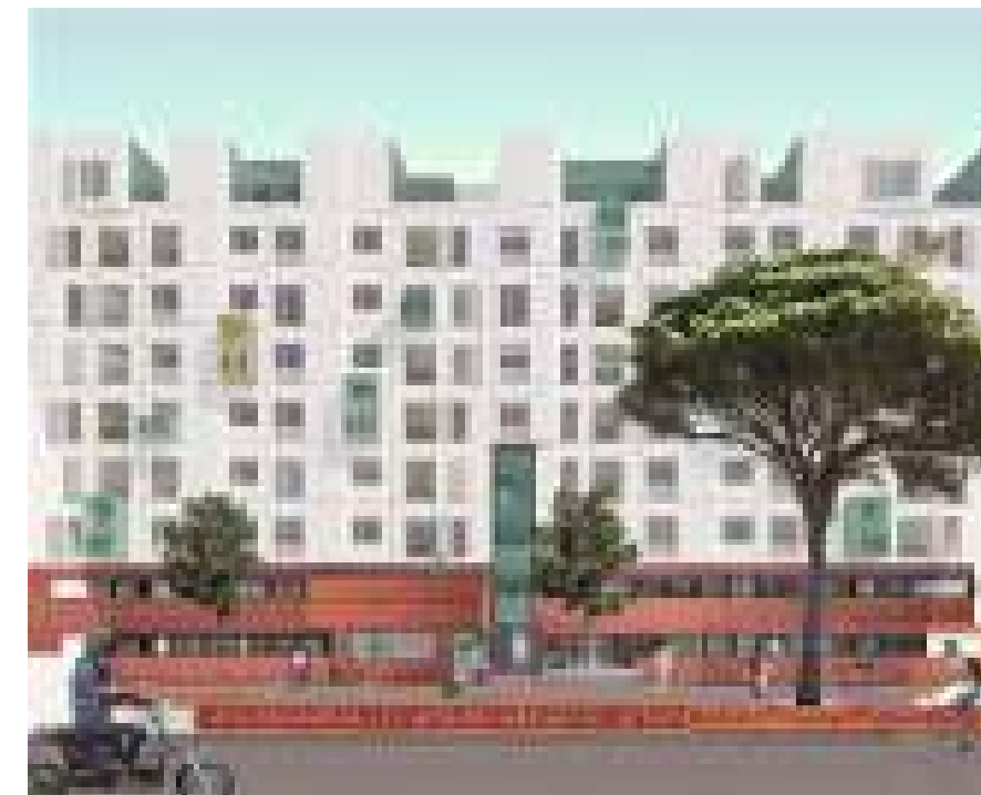
Fig.1: Rivitalizzazione di via dell'Archeologia. Vista di progetto in corrispondenza di una porzione dell'R5 con: podio rialzato, tipologie speciali che ridefiniscono l'attacco al suolo, piccole attività commerciali collegate alle tipologie casa-lavoro, atri passanti, nuove logge, nuove unità abitative in sopraelevazione.
