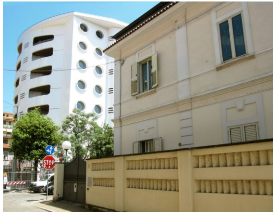
Foto 1 Esempio di demolizione e ricostruzione indifferente ai valori di contesto
