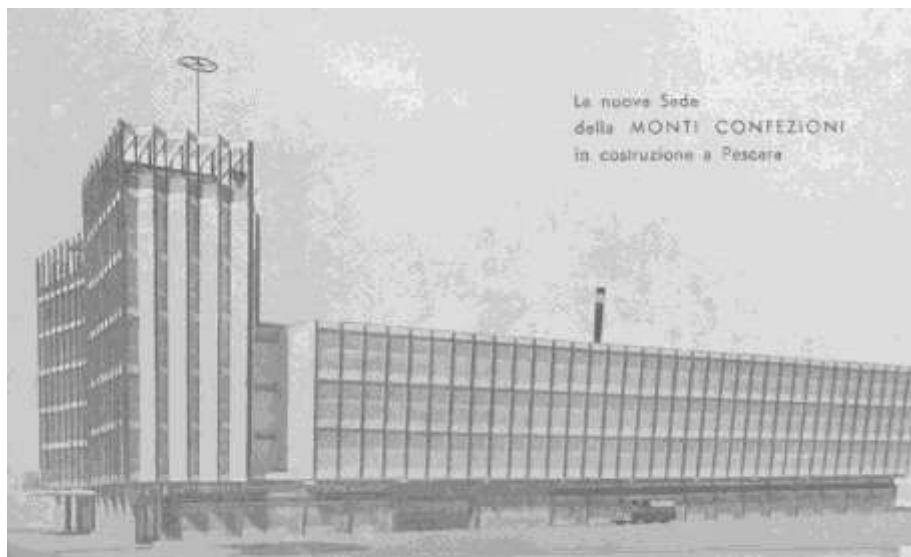
Fig. 1.6.1 Palazzo Monti, con la sua caratteristica facciata ondulata (nel prospetto in alto appena visibile), fu progettato dall'architetto Antonio Cataldi Madonna. Attualmente l'edificio ospita l'assessorato alla sanità della regione Abruzzo. L'immagine è tratta da Baccalà 1961, s.p.
