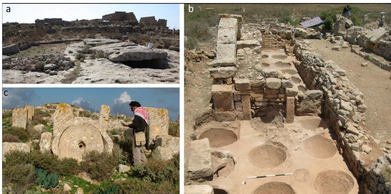
Fig. 3- Villaggi agricoli: a-Mgernes: veduta del foro-caravanserraglio, di alcune delle cisterne pubbliche e del granaio fortificato; b-Lamluda: veduta dei magazzini delle tabernae lungo il cardo maximus ; c-Jebbra: l'area della produzione di olio, veduta delle presse e macine. (foto O.Menzozi)
