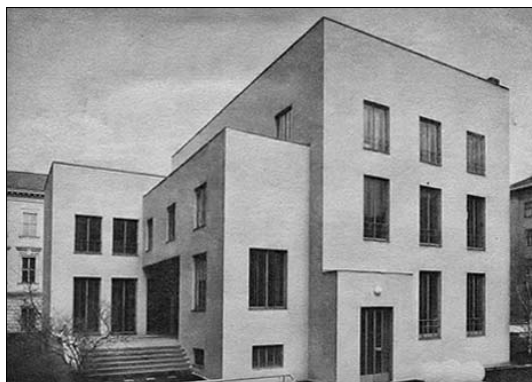
13. Vienna. Haus Wittgenstein sulla Kundmannngasse, 1926-28, esterno, stato attuale ( www.flickr.com ).
