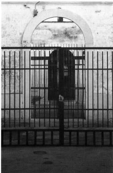
In questa e nelle pagine seguenti, alcuni scorci del Macello in allestimento (foto di Giuseppe Di Lullo)
