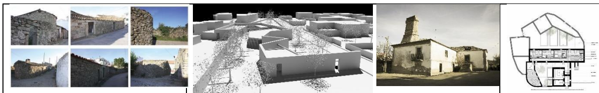
Figura 1: Coriscada: muros de granito, edifício Interface, Solar Menezes devoluto e hotel rural proposto
