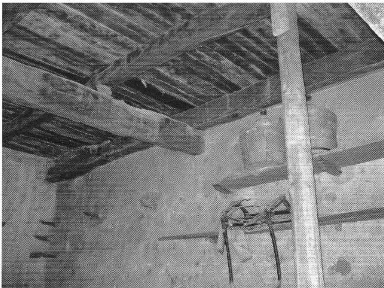
Fig. 2 - Solaio al piano terra in un'abitazione di Tossicchio (Teramo), foto C. Varagnoli.
