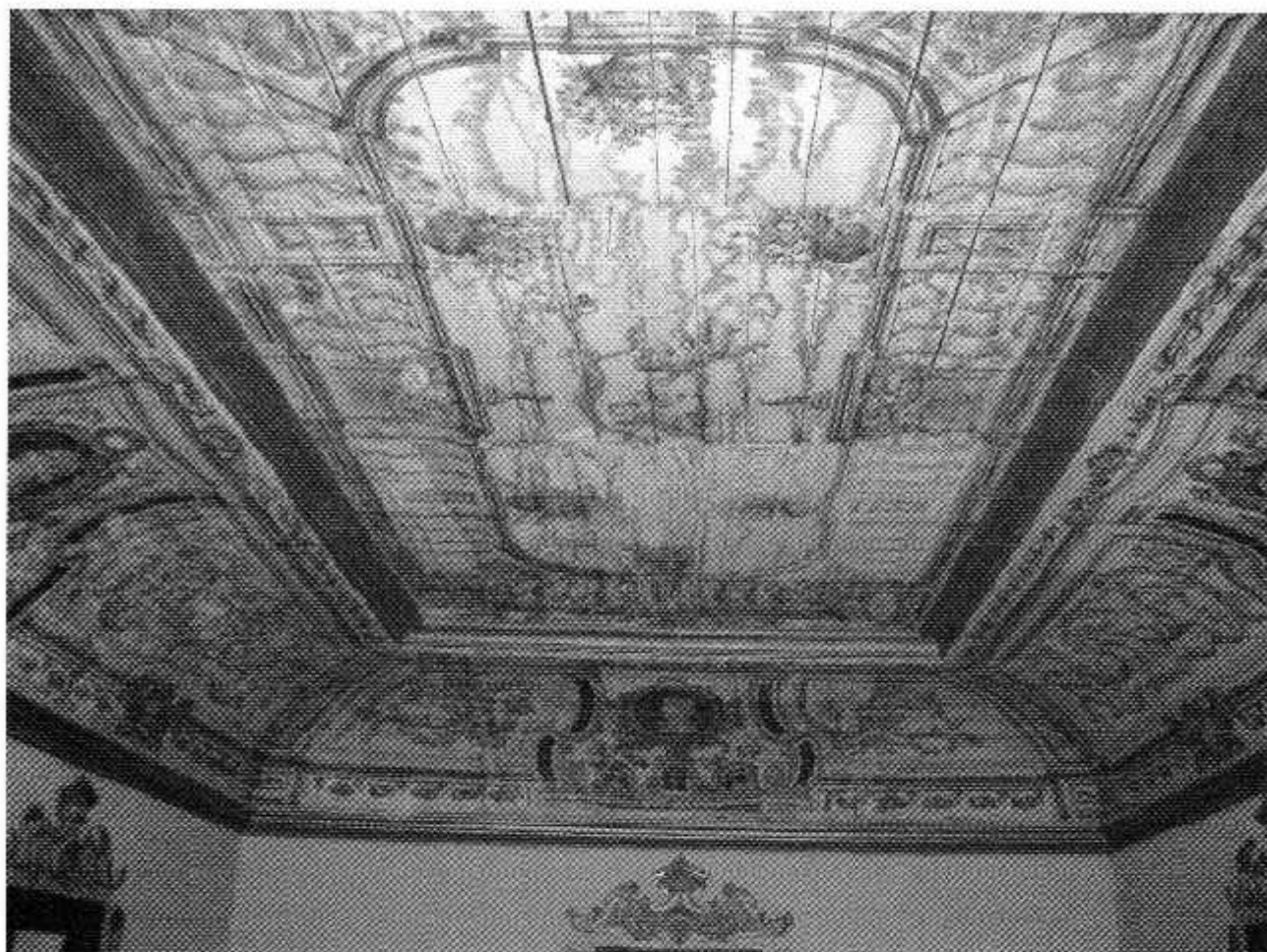
Fig. 8 – Pescocostanzo, Palazzo Ricciardelli, salone a piano nobile coperto con falsa volta in legno.
