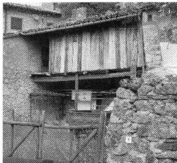
Fig. 11 - Gafio con parete di chiusura in tavole di legno a Pietruciamele (Teramo, foto C. Varughesi).
