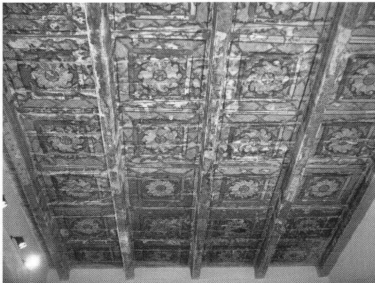
Fig. 3 – Ortona, palazzo Corvo (sec. XVII o successivo), solaio a piano nobile, con tavolato e regoli per concerto e decorazione a lacunari di pinda all'intradosso (foto C. Varagnoli)
