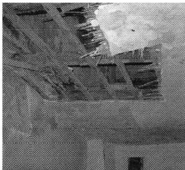
Fig. 10 - Cocullo (L'Aquila) controsoffitto in carne rifinito con malta di gesso in un ambiente al piano terra del centro abitato (foto C. Varughesi).
