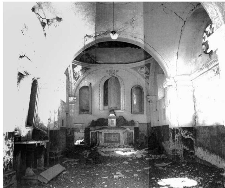
Fig. 6: vista generale dell'interno
