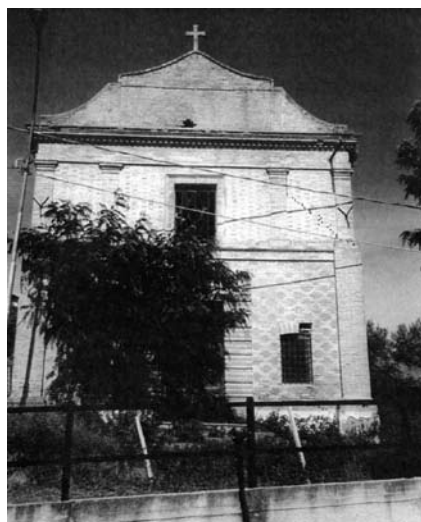
Fig. 3-4: vista e rilievo del prospetto
