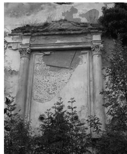
Fig. 6: particolare del prospetto
