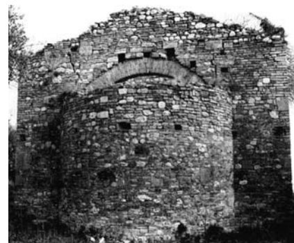
Fig. 4: vista prospetto abside
