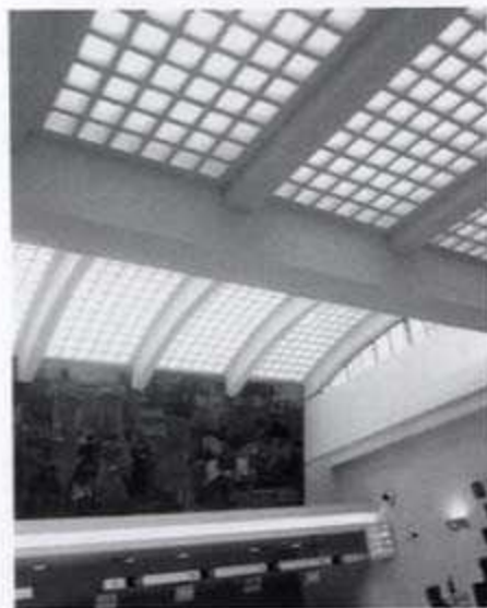
Fig. 6 - Pescara. Palazzo delle Poste. Copertura attuale del salone interno (foto dell'A.).
