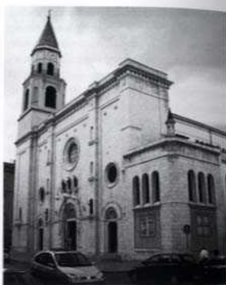
Fig. 9 - Pescara. C. Bazzani. Cattedrale di S. Cetceo. Vista attuale del fronte anteriore (foto dell'A.).
