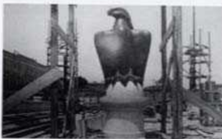
Fig. 3 - Pescara. Ponte Littorio. Fase di montaggio di una delle quattro aquile in bronzo di coronamento alle colonne del ponte (ibidem).
