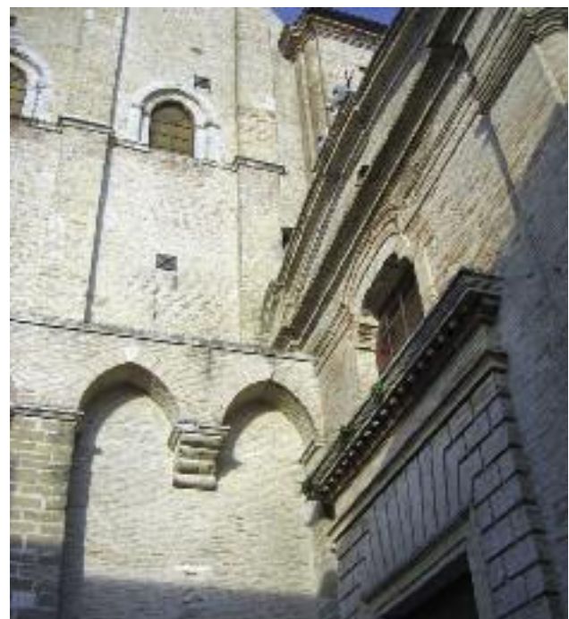
Fig. 1 - Nicola Maria Pietrocola. Progetto di consolidamento del coro di Santa Maria Maggiore a Vasto, 1838: Archivio di Stato di Chieti (ASC), Fondo Intendenza Affari Ecclesiastici, chiese di Regio Patronato 1827-1866, b. XIII
