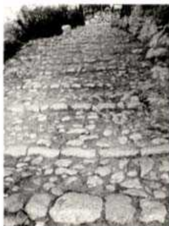
Fig. 1 - Breccionata con cordone in pietra calcarea nelle strade di Albe Vecchia.
