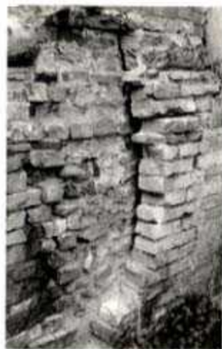
Figura 16 – Foderu laterizia male ammorsata, per l'assenza di mattoni di testa (diatoni) in palazzo Vergili (sec. XVIII, su preesistenze) a Lanciano (foto C. Varagnoli 1995)
