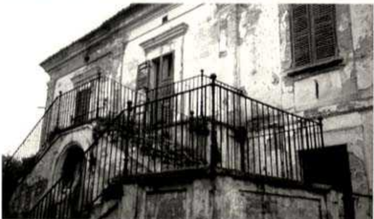
Figura 25 - Casa rurale nei pressi di Pietraroia (sec. XIX) con il sottile intonaco di finitura (foto C. Catilli 1995).
