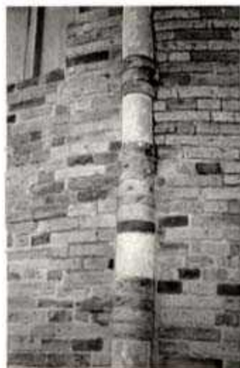
Figura 20 – Semicolonne in laterizio e conci lapidei nell'abside di S. Angelo (o S. Maria Maggiore) a Pianella, con restauri (foto C. Varagnoli 1992).
