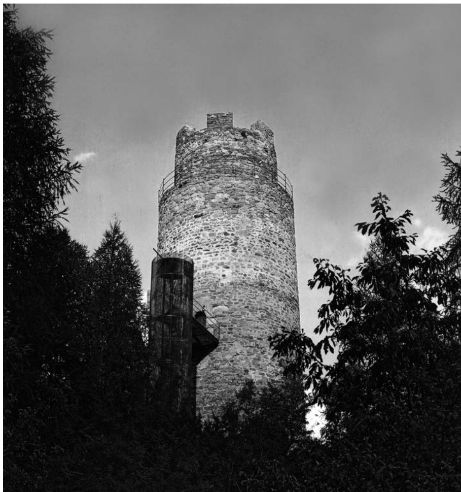
4. Tubre (BZ), la torre Reichenberg recuperata a casa d'abitazione (arch. W. Tscholl)
