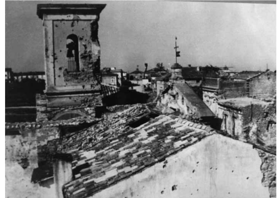
Ortona, i danni al patrimonio edilizio e monumentale
