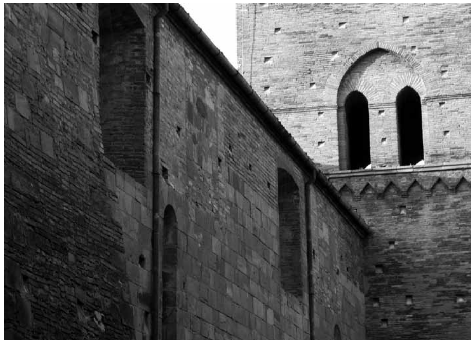
Lanciano, chiesa di S. Biagio, particolare del fianco meridionale
