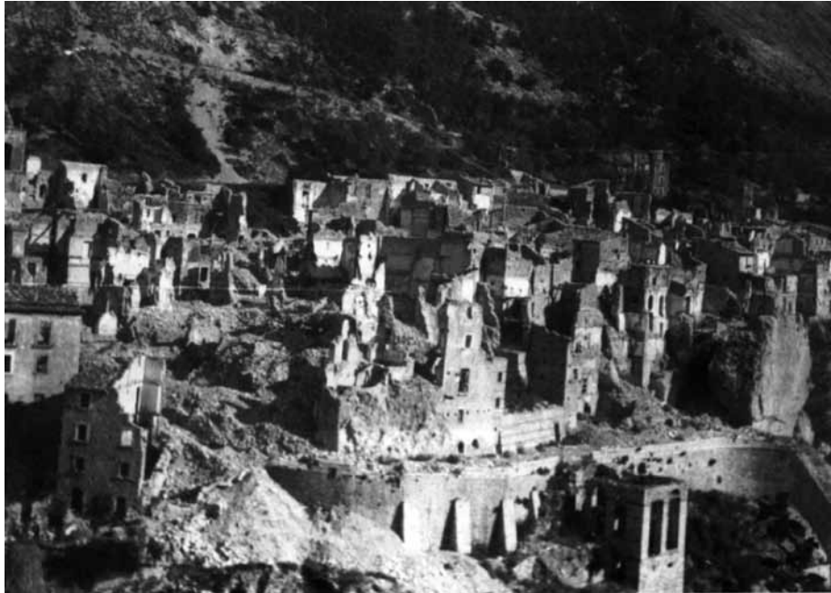
Lettopalena, le distruzioni al patrimonio edilizio
