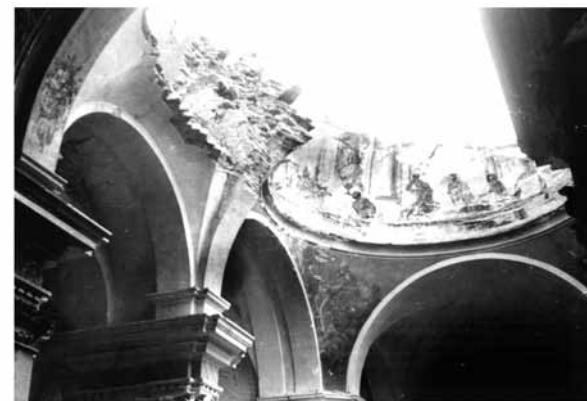
Penne, chiesa di S. Maria in Colle Romano, il crollo della cupola. Su concessione del Ministero per i Beni e Attività Culturali, Soprintendenza PSAE per l'Abruzzo, L'Aquila, archivio fotografico
