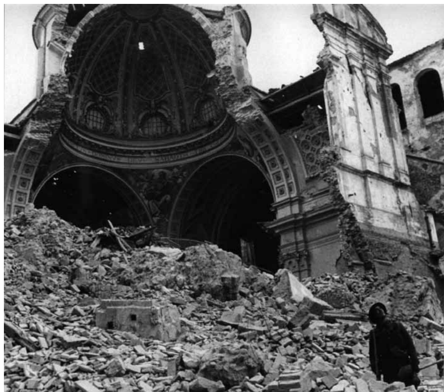
Ortona, cattedrale di S. Tommaso, il crollo della cupola
