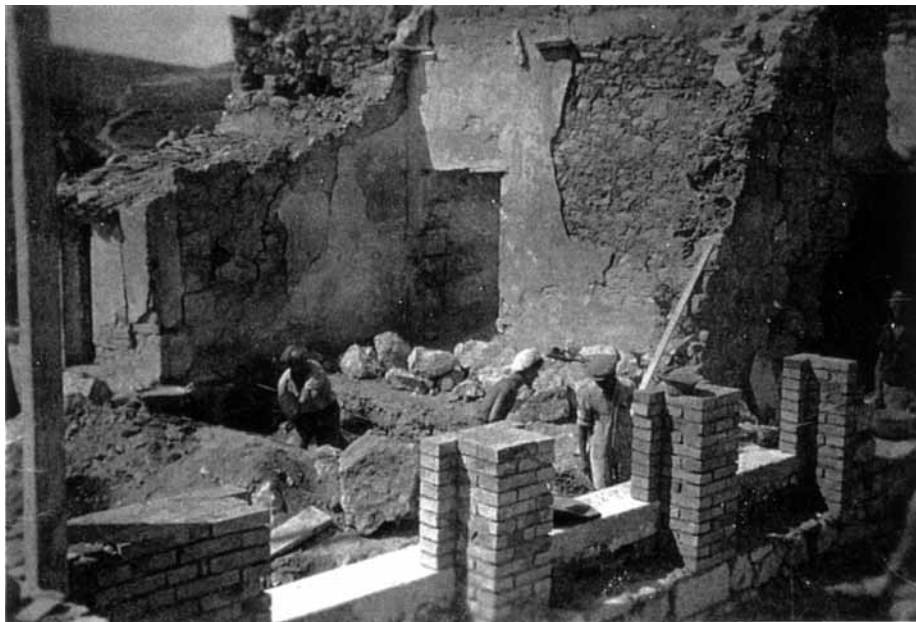
Montenerodomo, la ricostruzione delle case sulla traccia delle antiche fondazioni. Archivio privato Macy Whitehead, Maine-USA
