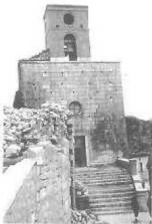
La chiesa di S. Martino e il palazzo del comune nell'immediato dopoguerra (archivio privato Macy Whitehead, Maine-USA).
