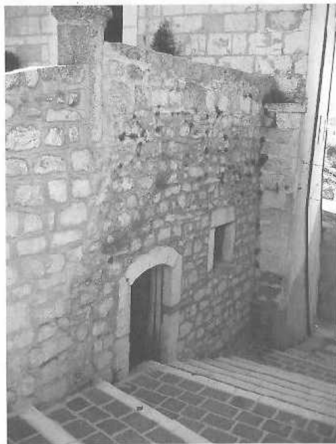
Le case ricostruite lungo via Roma in una foto recente.
