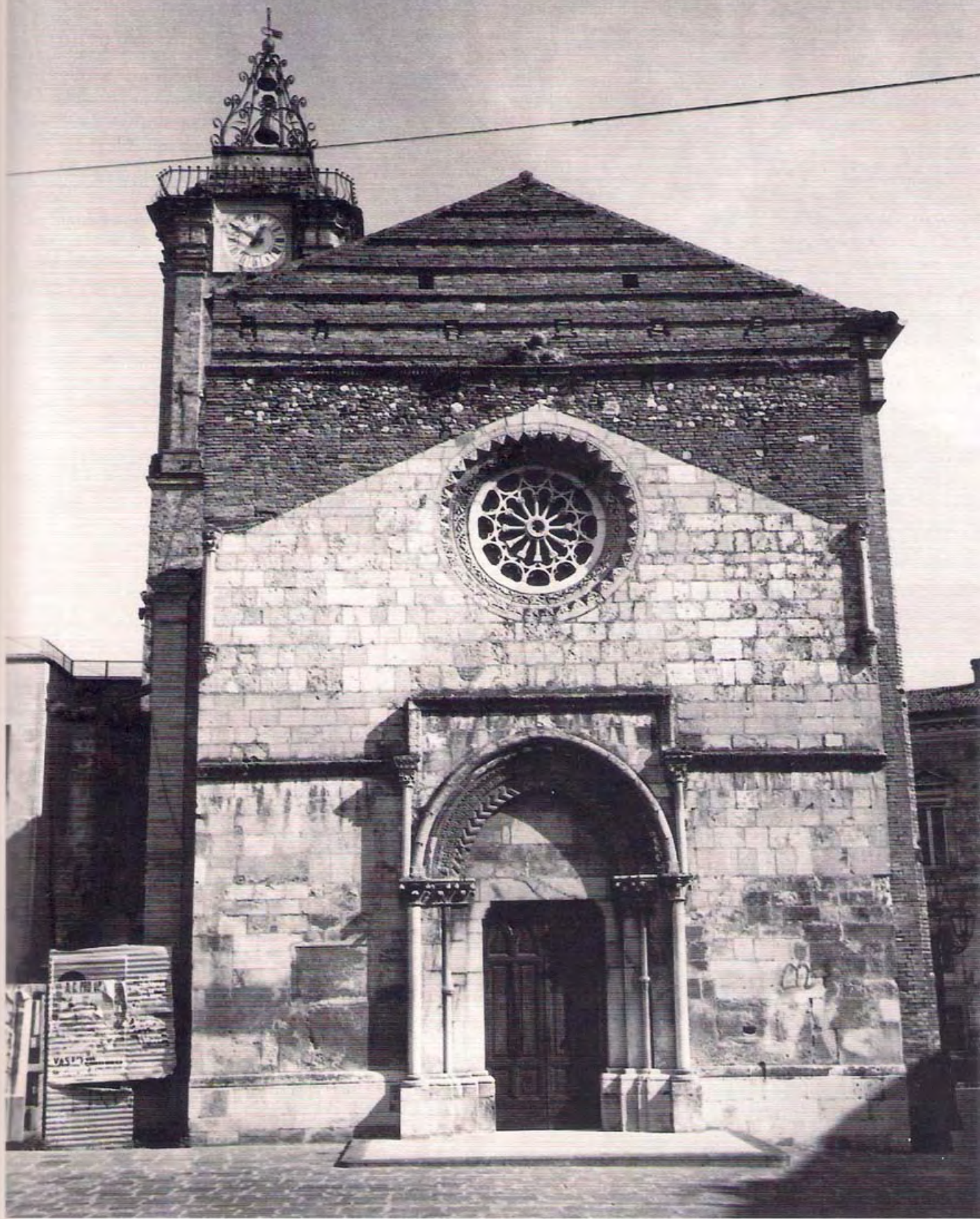
Fig. 1 - Vasto, S. Giuseppe, la facciata prima dei recenti restauri (foto 1980 circa).
