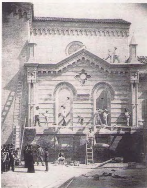
Figg. 11, 12 - S. Giuseppe, l'interno realizzato da F. Benedetti; costruzione della cappella del Sacro Cuore.
