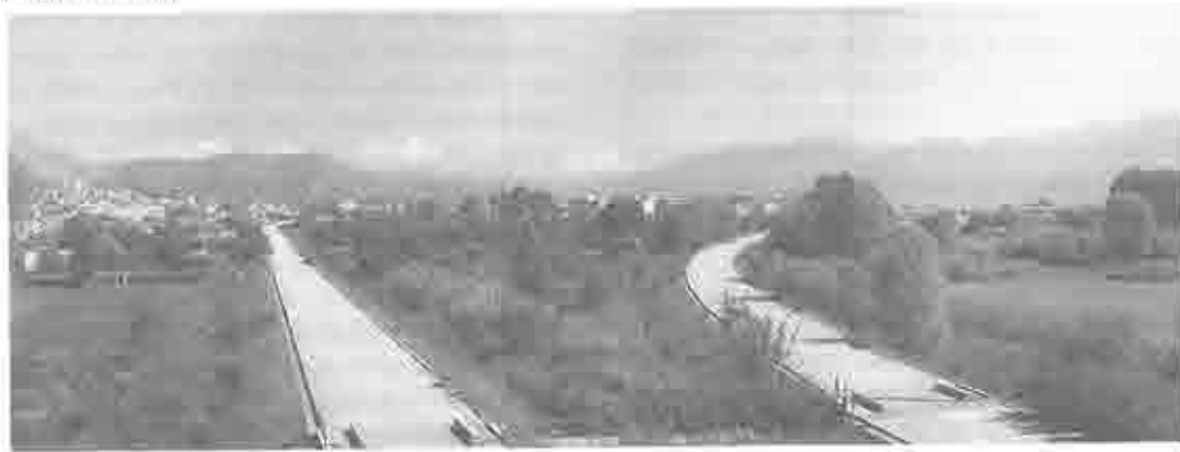
Piana di Venafro - Completamento della linea ferroviaria Venafro-Rocca d'Evandro-San Vittore. Cantieri nei pressi di Venafro
