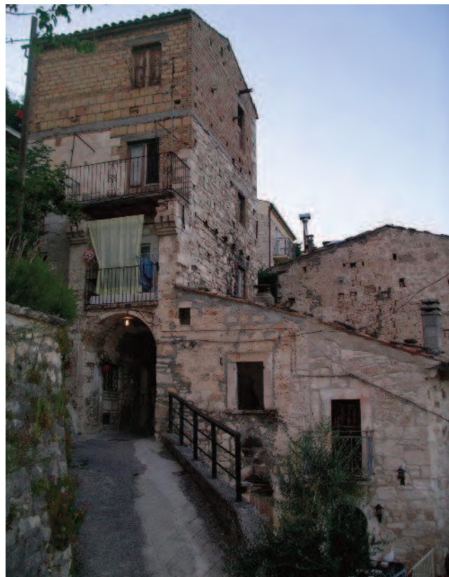
Fig.1, 2 – Pennapiedimonte (Ch), edilizia del centro storico realizzata in pietra da taglio (foto C. Varagnoli 2010).
