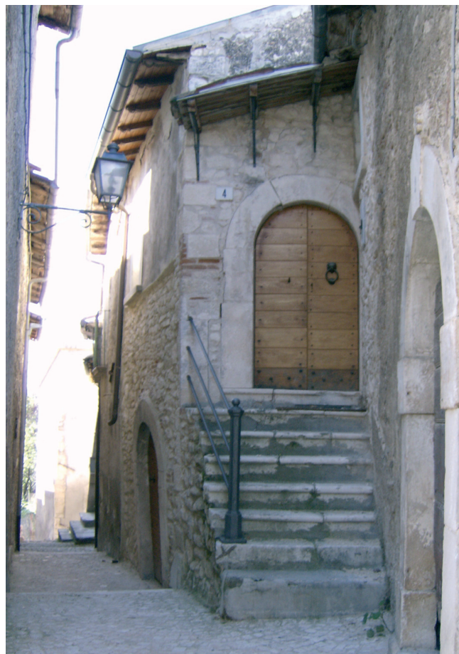
Fig. 15 Particolare di una scala esterna in via Grimaldi
