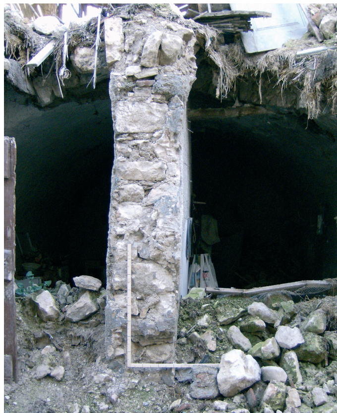
Fig. 11 Particolare della volta in bozze lapidee in via Roma
