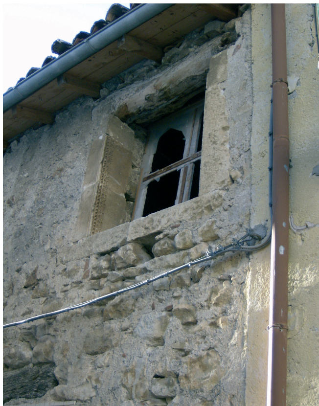
Fig. 6 Particolare di una finestra con architrave ligneo
