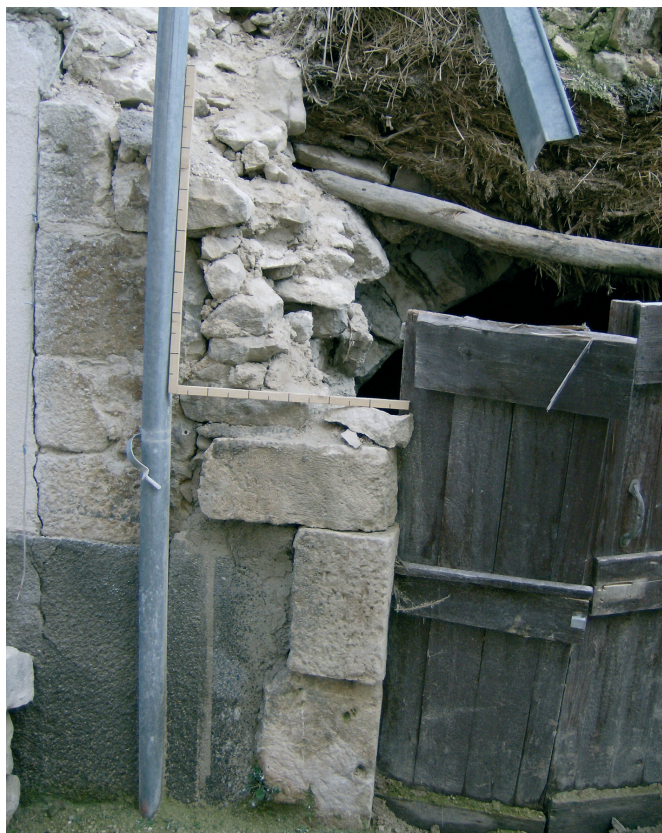
Fig. 10 Particolare del piedritto di una apertura in via Roma
